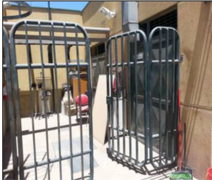
Ilustración 12. Sala de mantención.
