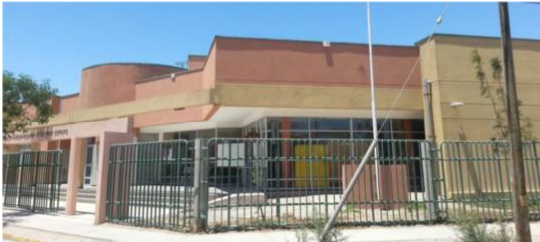
Ilustración 1. Fachada principal del edificio
