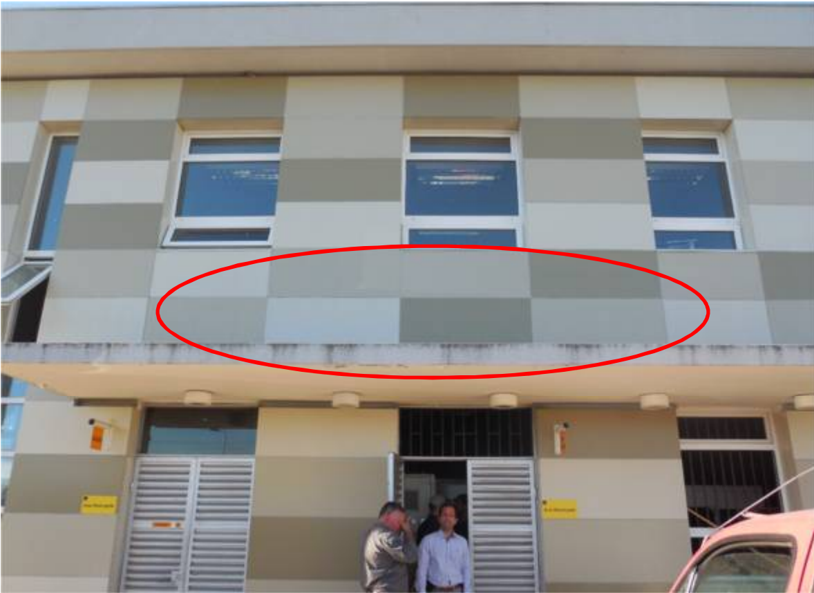
Ilustración 14: punto de instalación inversor.
