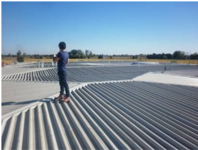
Ilustración 11: vista este cubierta edificio.
