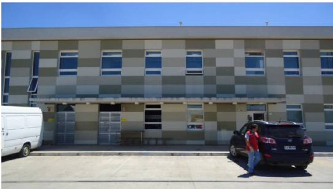
Ilustración 1. Fachada del edificio.
