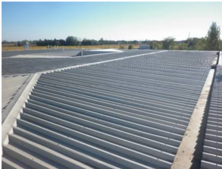
Ilustración 13: vista sur cubierta edificio.
