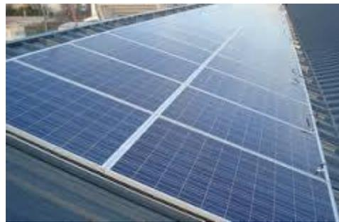
Ilustración 7: ejemplo paneles fotovoltaicos integrados en cubierta.
