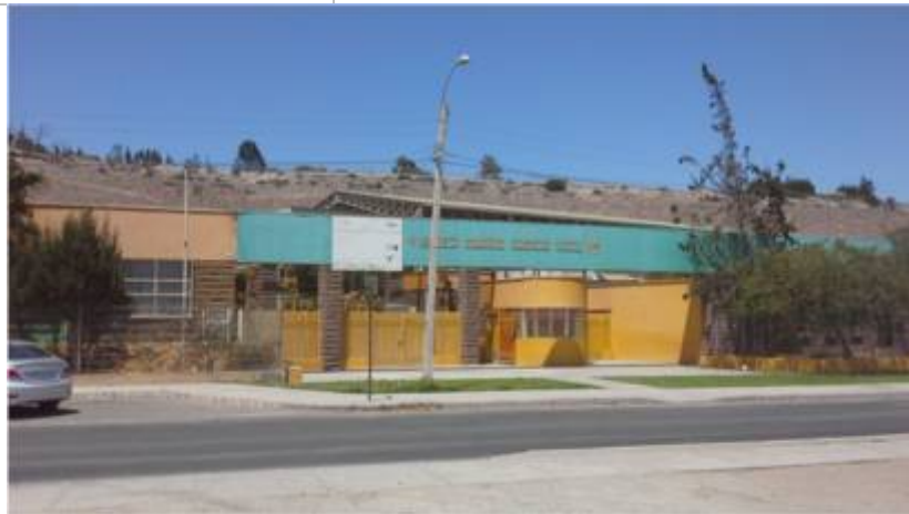
Ilustración 1. Fachada del edificio.
