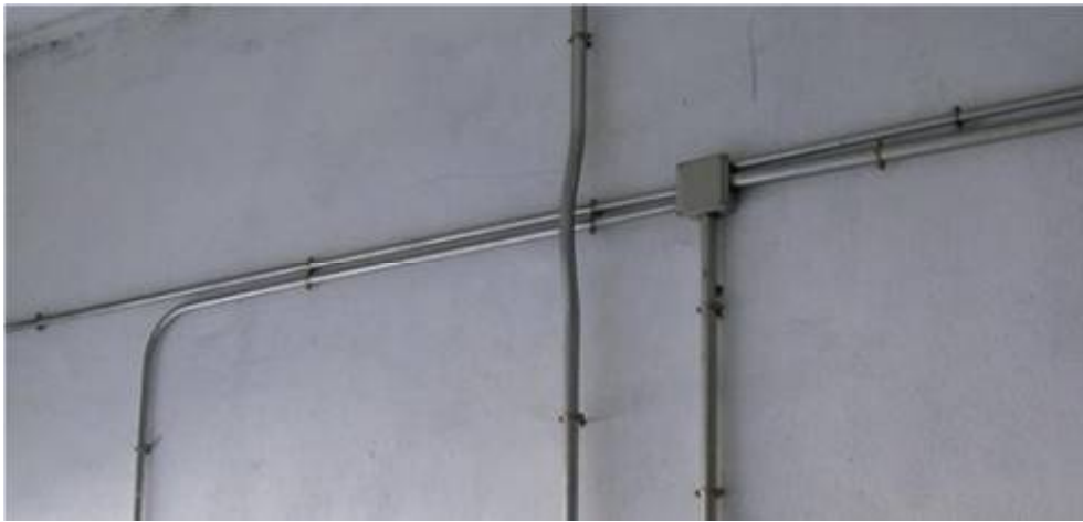
Ilustración 13. Ejemplo de instalación bajo tubo.
