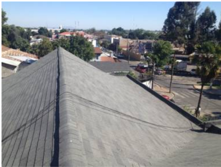
Ilustración 11: vista este tejado 2.
