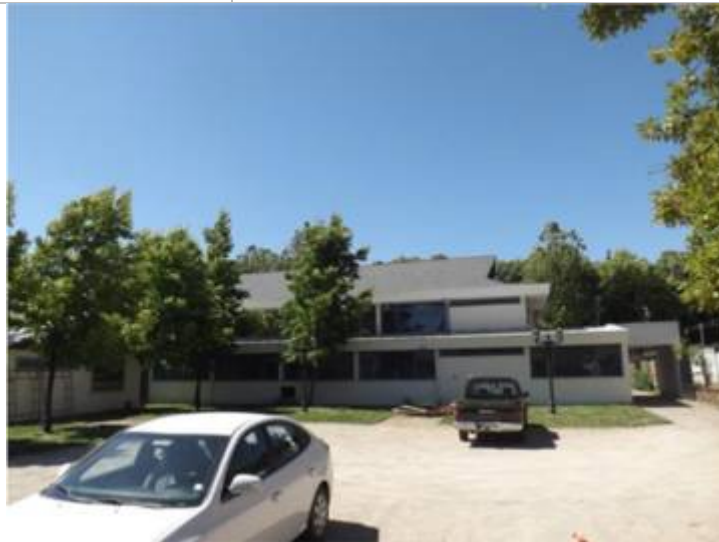
Ilustración 1. Fachada del edificio.
