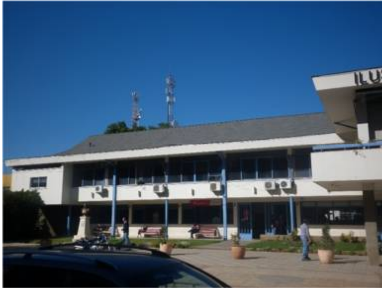
Ilustración 10: vista norte del edificio.
