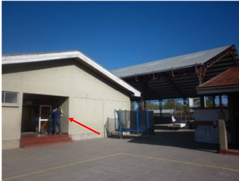
Ilustración 15: lugar tablero de conexión y cubierta a intervenir.
