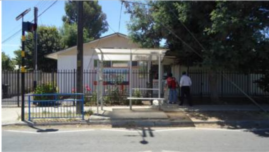
Ilustración 1. Fachada del edificio.
