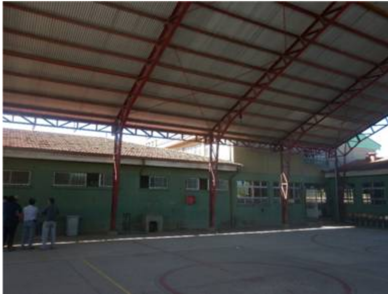
Ilustración 13: vista edificio norte adyacente.
