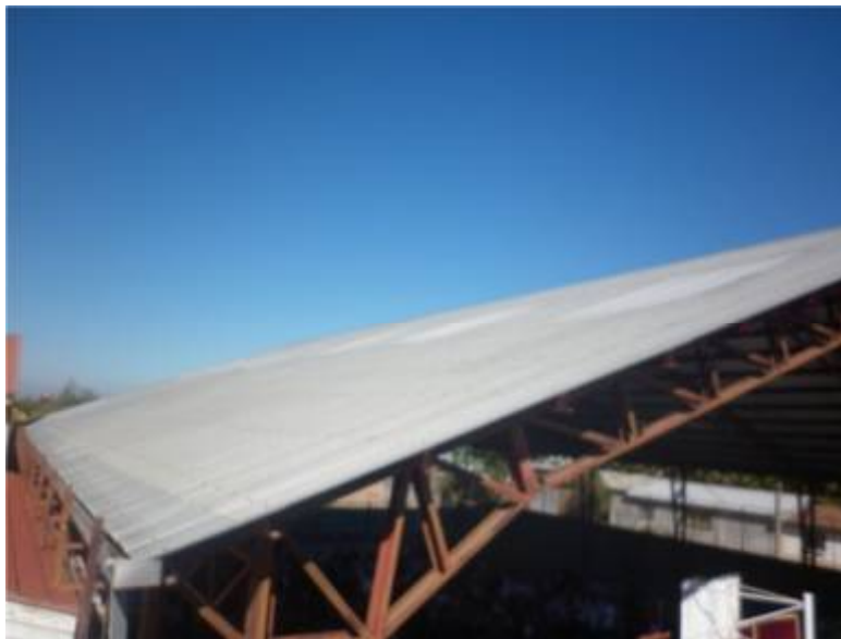
Ilustración 12: vista oeste de la cubierta.
