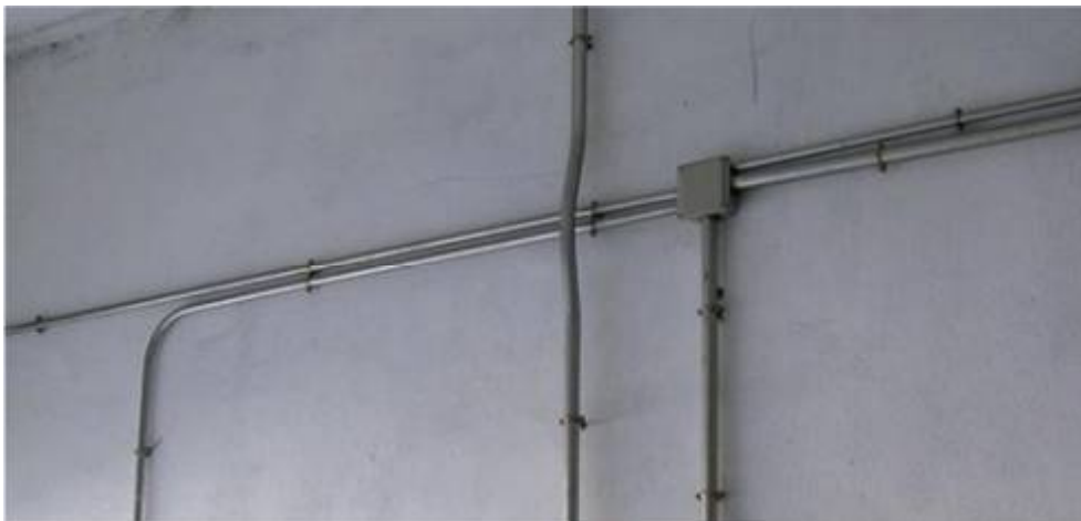
Ilustración 8. Ejemplo de instalación bajo tubo.
