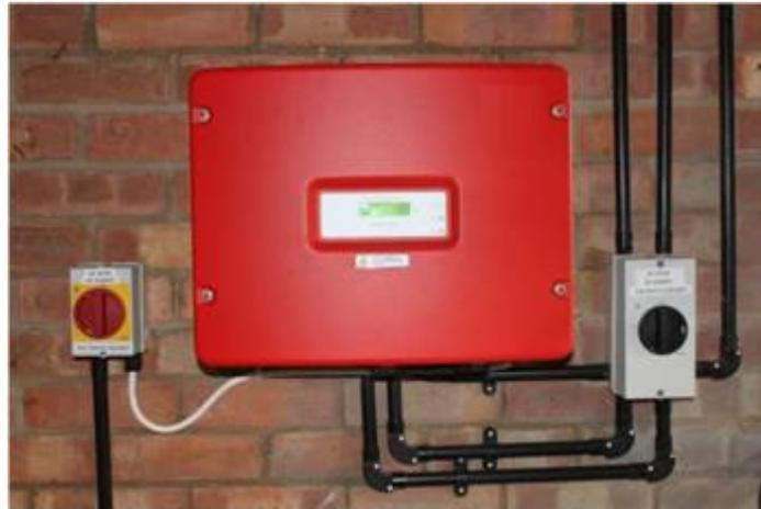
Ilustración 5 -Típico montaje de un inversor
