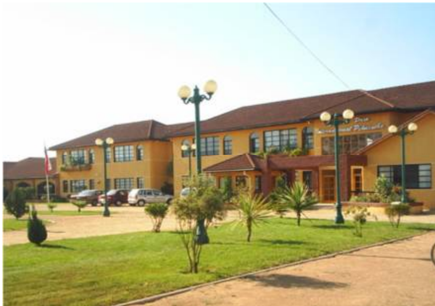
Ilustración 1. Fachada principal del edificio
