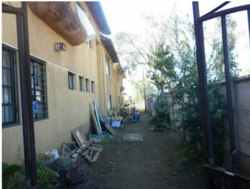
Ilustración 12: detalle zona de canalización entre inversor y punto de conexión.
