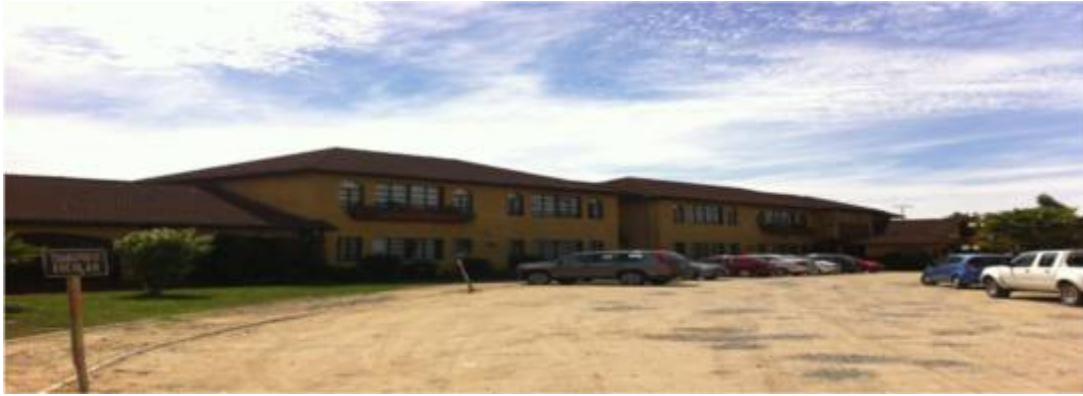
Ilustración 9: fachada del edificio.
