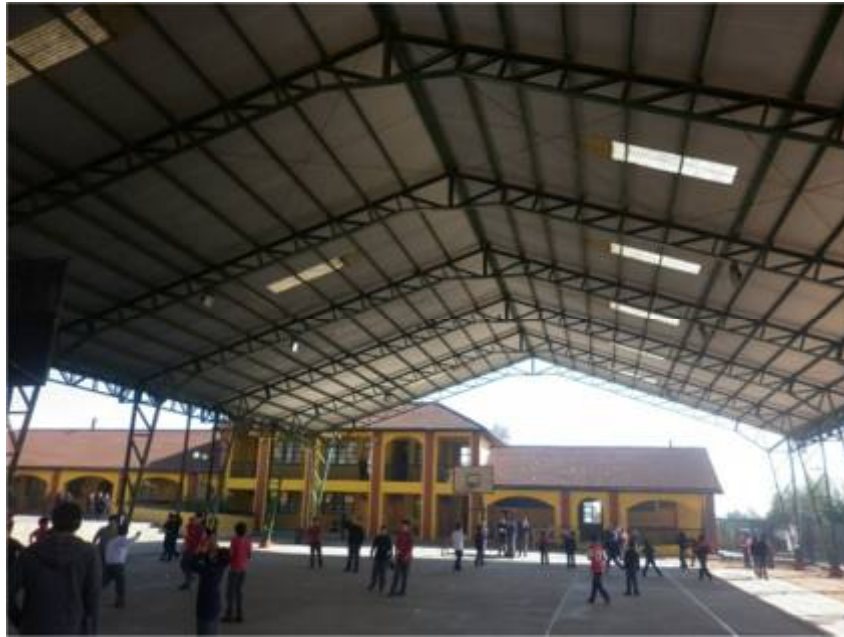
Ilustración 11: vista inferior de la cubierta.
