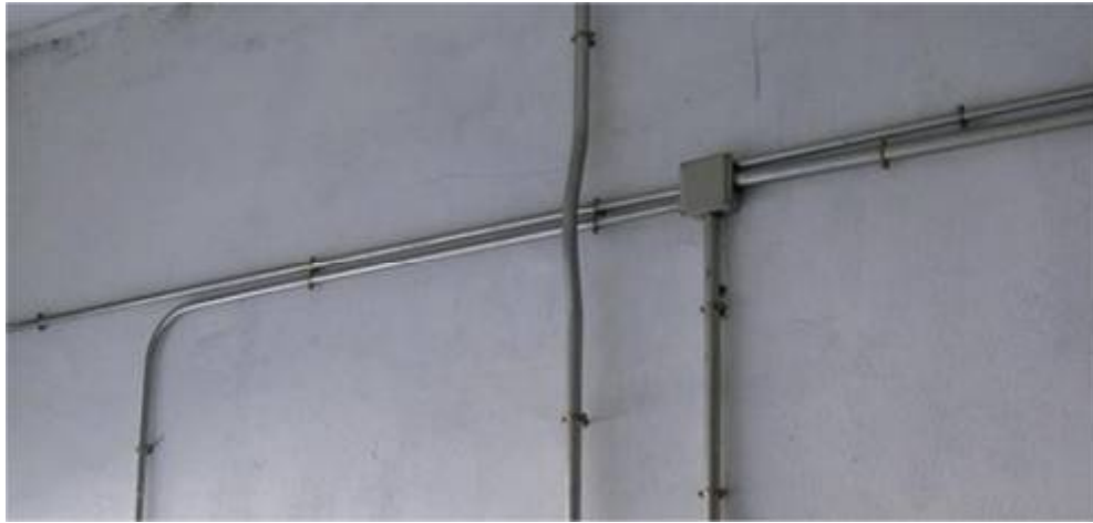
Ilustración 8: ejemplo de instalación bajo tubo.
