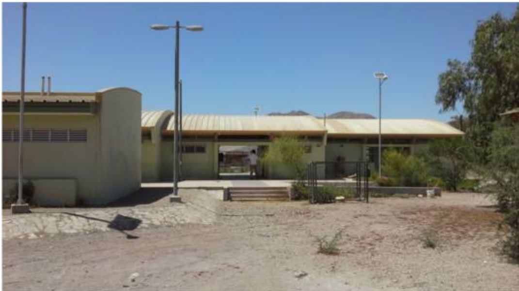
Ilustración 13: vista noreste cubierta edificio.
