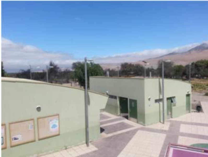
Ilustración 14: vista este cubierta edificio.
