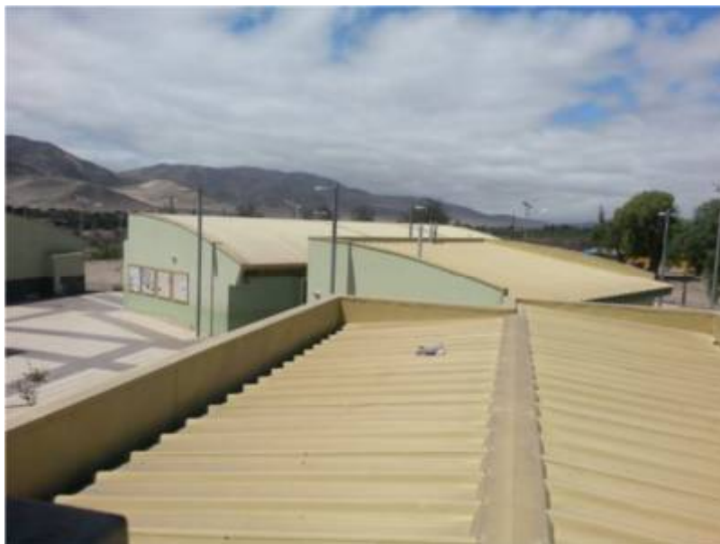
Ilustración 5: detalle cubierta de edificio.
