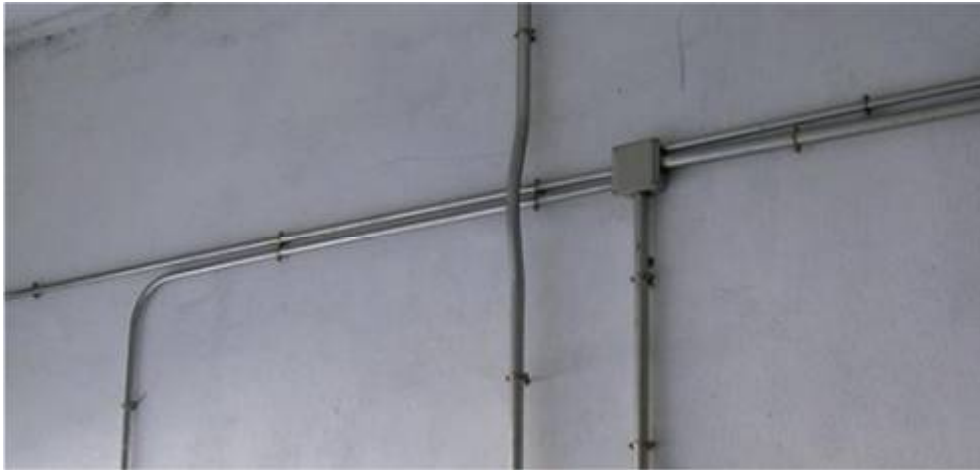
Ilustración 9. Ejemplo de instalación bajo tubo.
