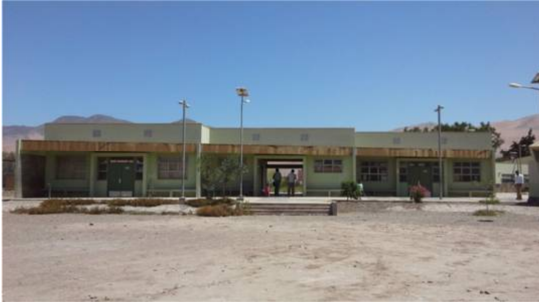
Ilustración 12: vista sur edificio.
