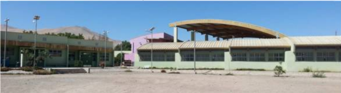
Ilustración 1. Fachada del edificio.
