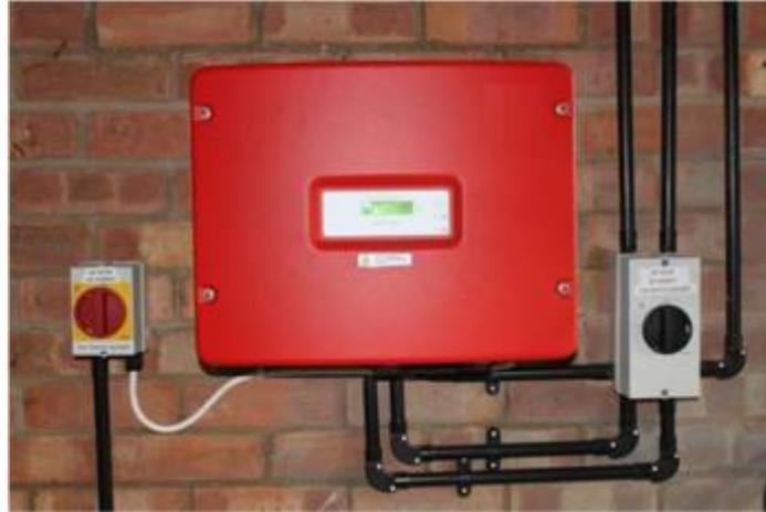
Ilustración 6 -Típico montaje de un inversor
