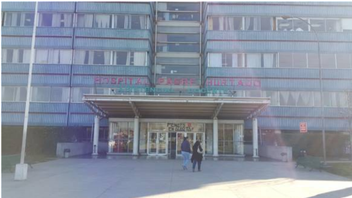
Ilustración 1 - Fachada del edificio
