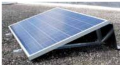
Ilustración 7 – Estructura de anclaje Típica para módulos fotovoltaicos
