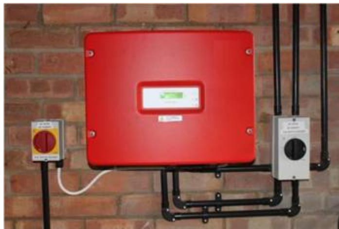
Ilustración 6 -Típico montaje de un inversor
