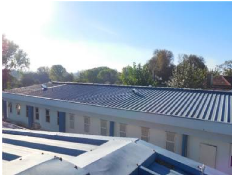
Ilustración 12: vista oeste cubierta edificio n° 2.
