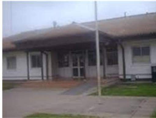
Ilustración 1. Fachada del edificio.
