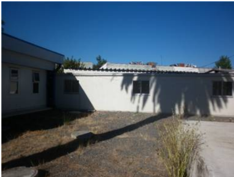
Ilustración 15: punto de instalación inversor.
