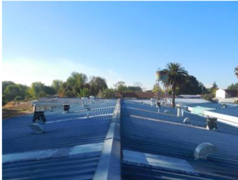
Ilustración 13: vista oeste cubierta edificio n°1.
