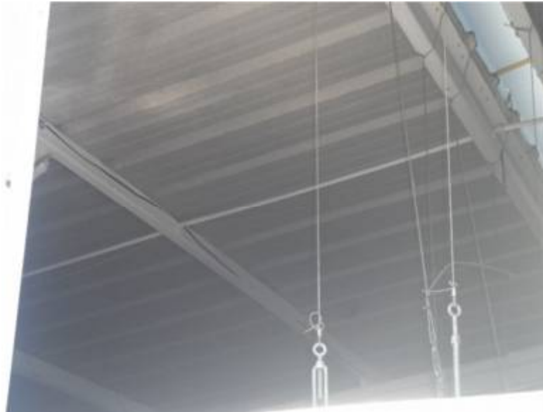
Ilustración 14. Detalle estructura de cubierta.
