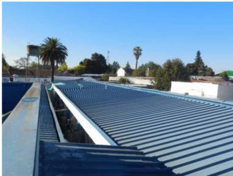
Ilustración 13: vista este cubierta edificio n°3.
