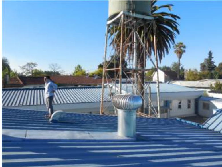
Ilustración 11: vista oeste detalle deposito de agua.
