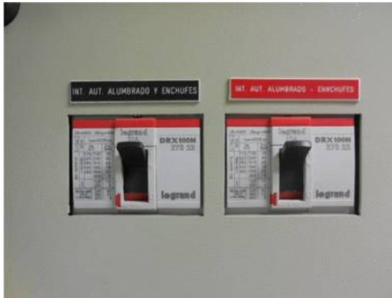
Ilustración 5: detalle protecciones de tablero.
