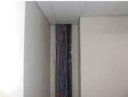
**Ilustración 15** apertura canalización desde el techo. Sala eléctrica piso 3.
