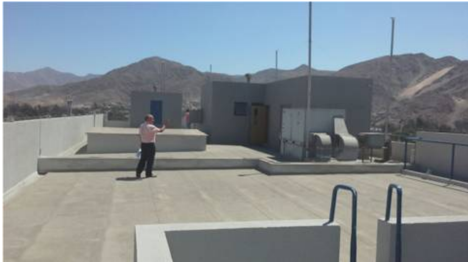
Ilustración 5: forma de acceso. Escalera interior de servicio.
