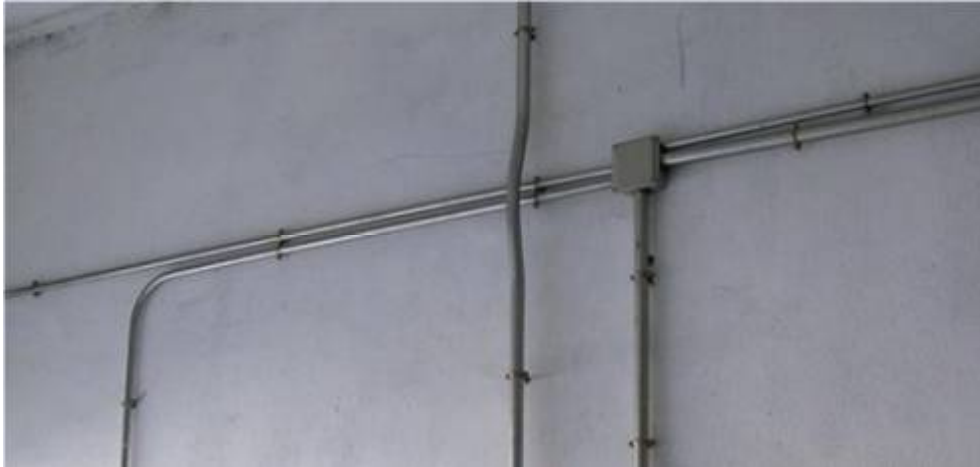
Ilustración 9. Ejemplo de instalación bajo tubo.
