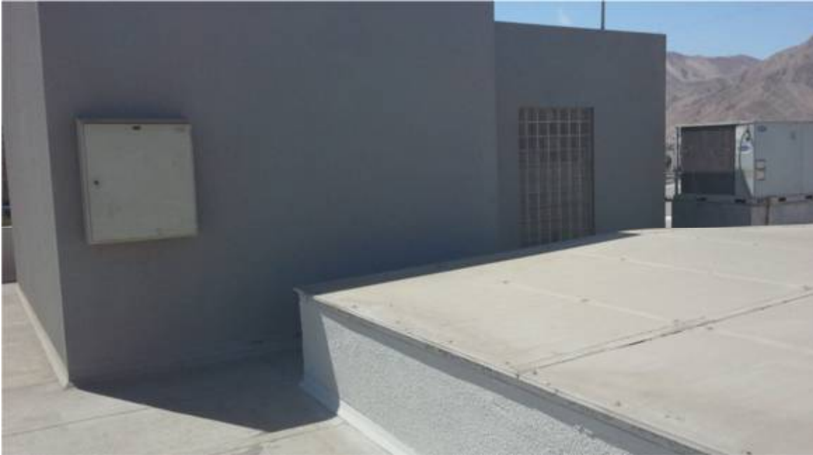
Ilustración14: posición del inversor.
