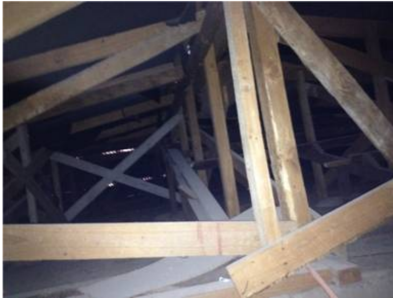
Ilustración 16: detalle estructura de la cubierta.
