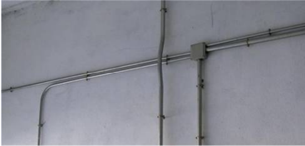
Ilustración 9. Ejemplo de instalación bajo tubo.
