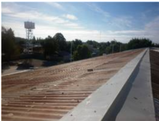
Ilustración 5: vista de cubierta desde ventana de acceso.
