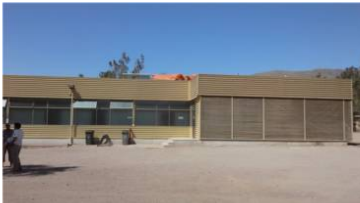
Ilustración 1. Fachada del edificio.
