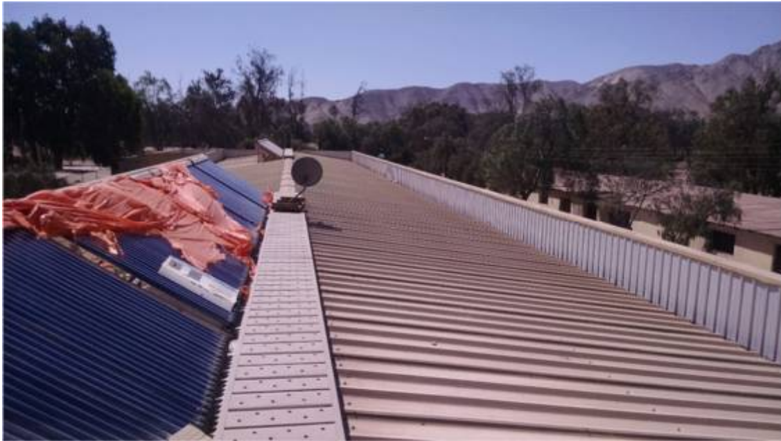
Ilustración 15: detalle cubierta del edificio.
