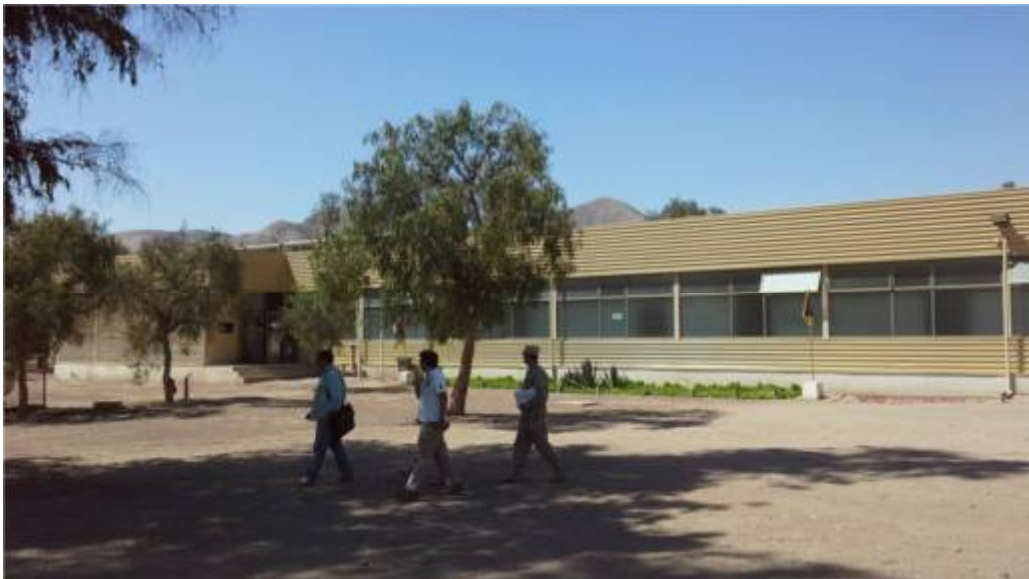
Ilustración 13: vista suroeste edificio.
