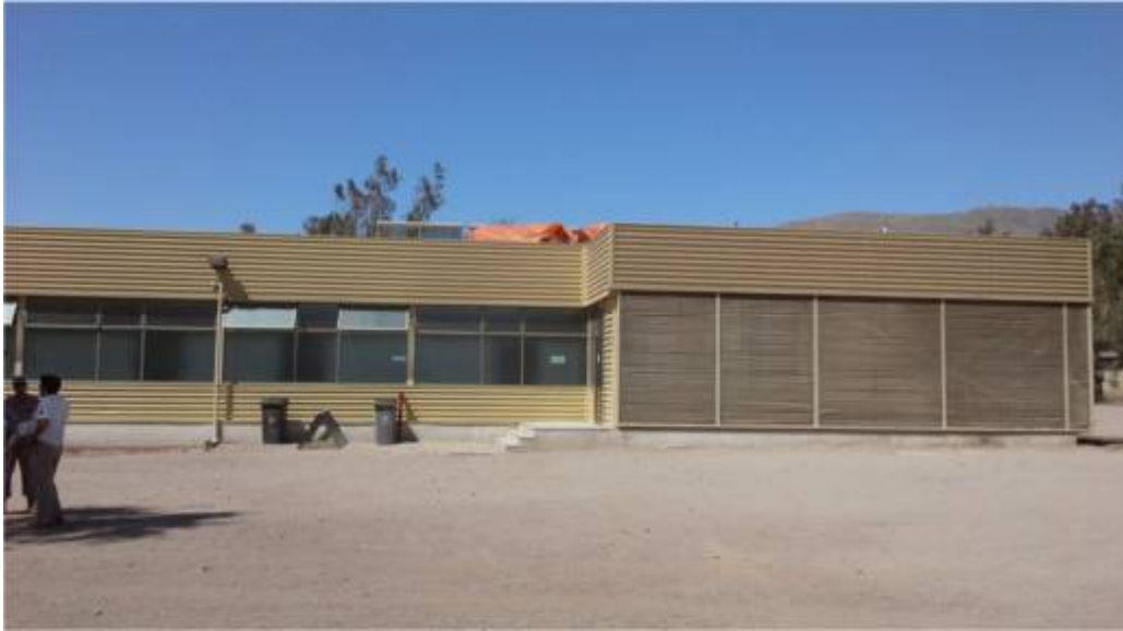
Ilustración 12: vista sur edificio.
