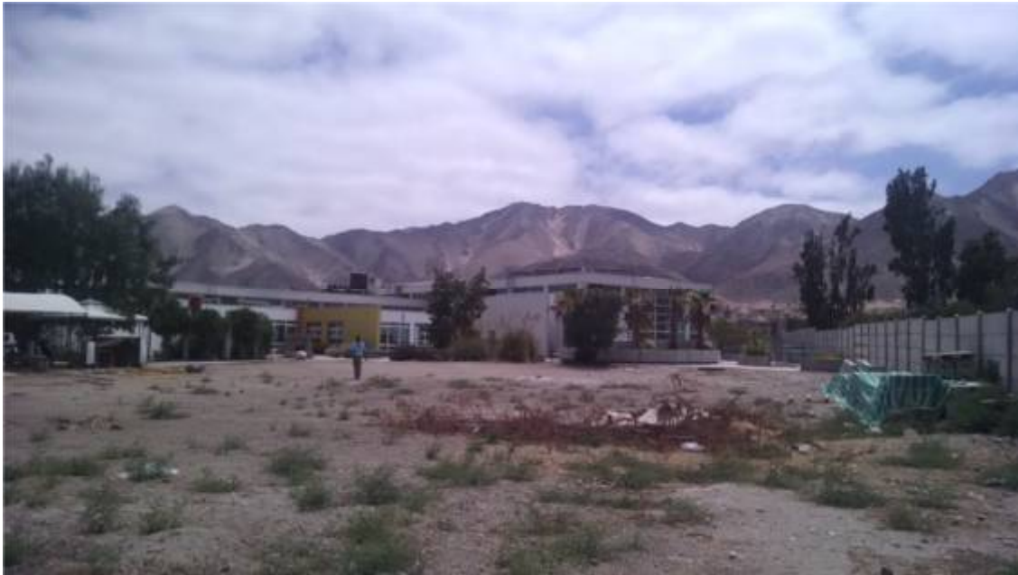
Ilustración 18: vista sur edificio.
