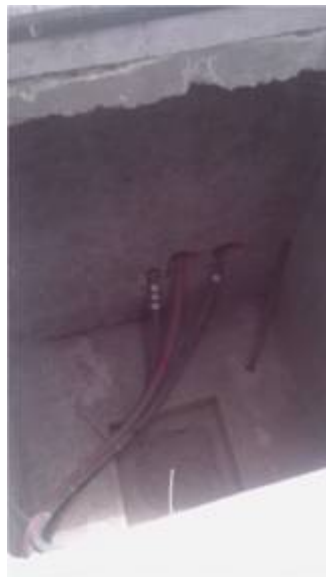
Ilustración 19: detalle canalización soterrada.
