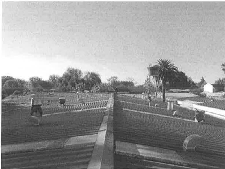
Ilustración: vista de la cubierta.
