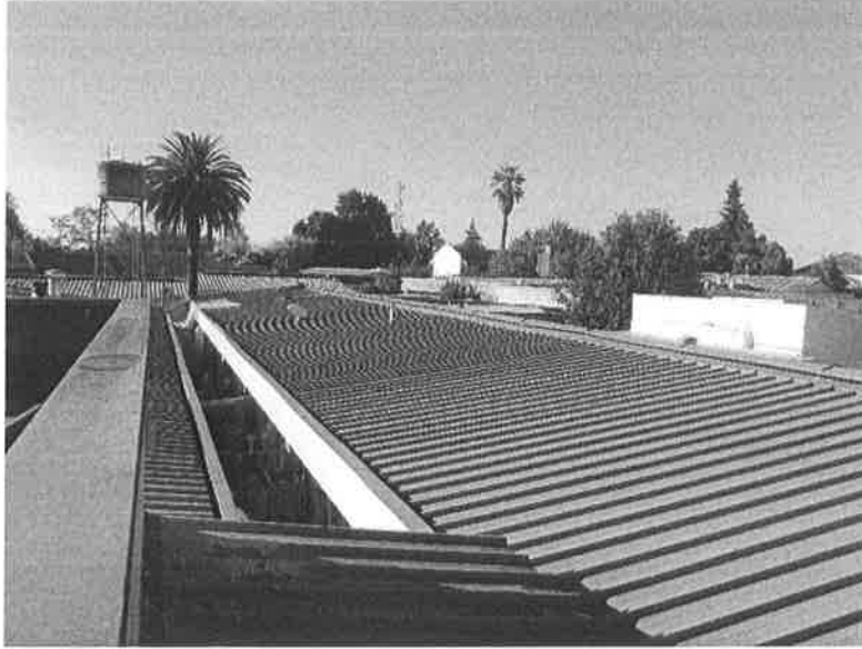
Ilustración: vista de la cubierta.
