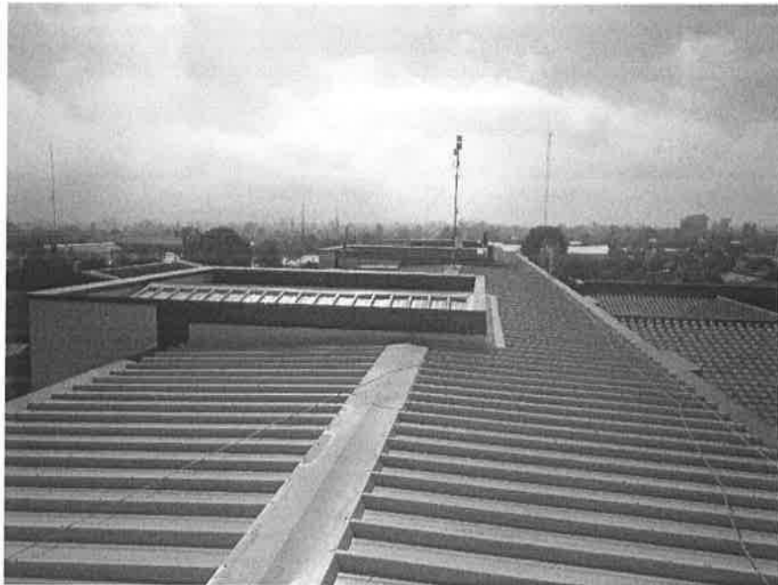
Ilustración: vista sur de la cubierta.
