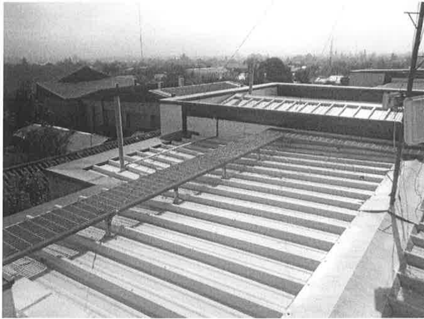
Ilustración: esquina noreste de la cubierta.
