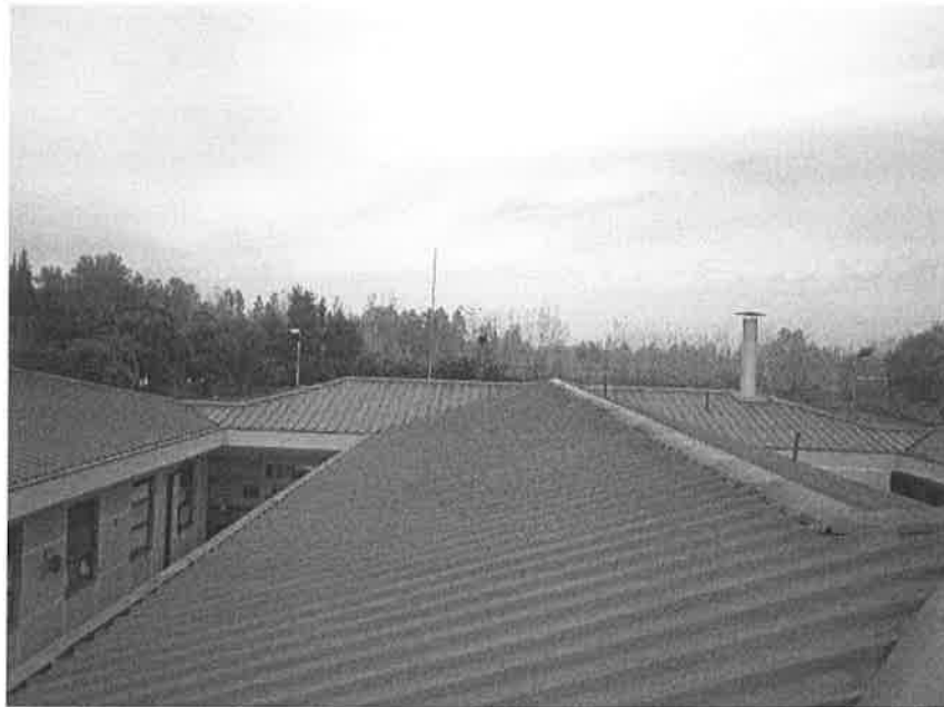
Ilustración: vista norte de las cubiertas.
