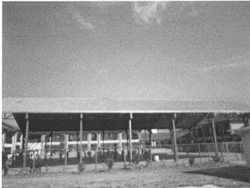
Ilustración: vista noreste de la cubierta seleccionada.
