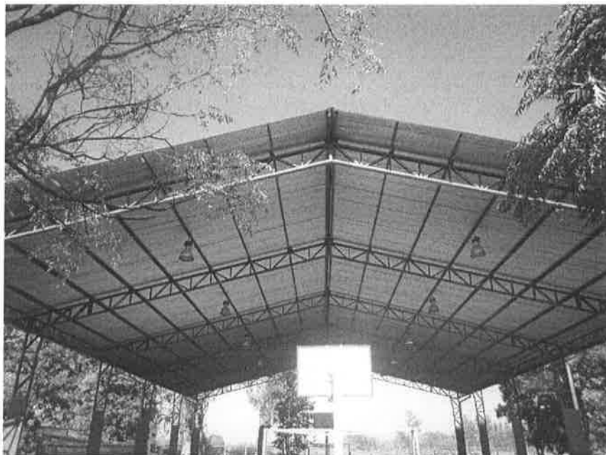
Ilustración: vista noreste de la cubierta seleccionada.
