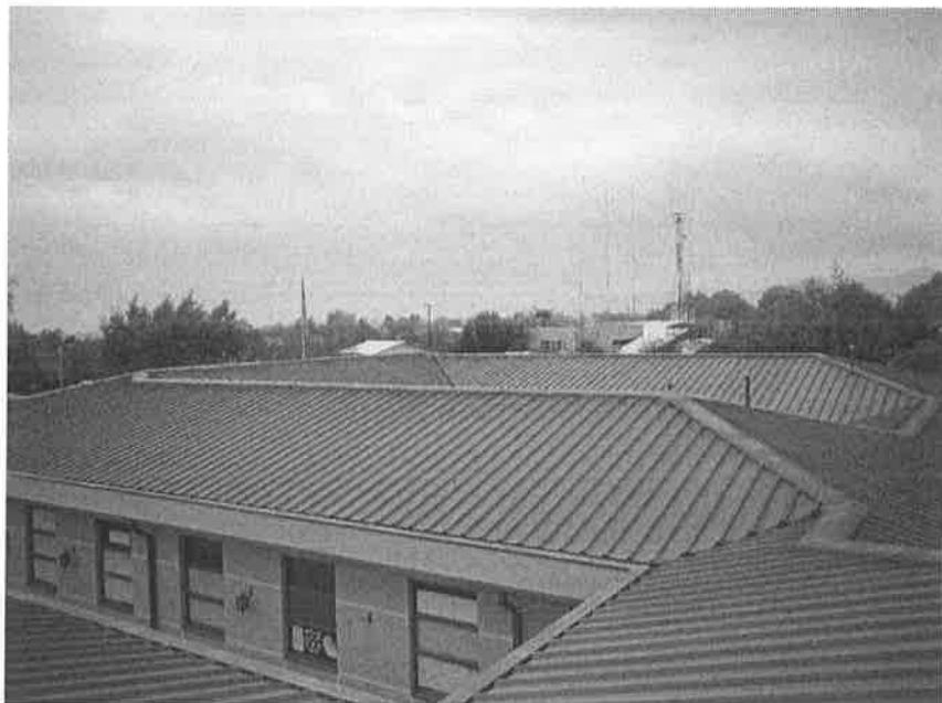
Ilustración: vista patio ubicación vista desde una de las cubiertas seleccionadas
