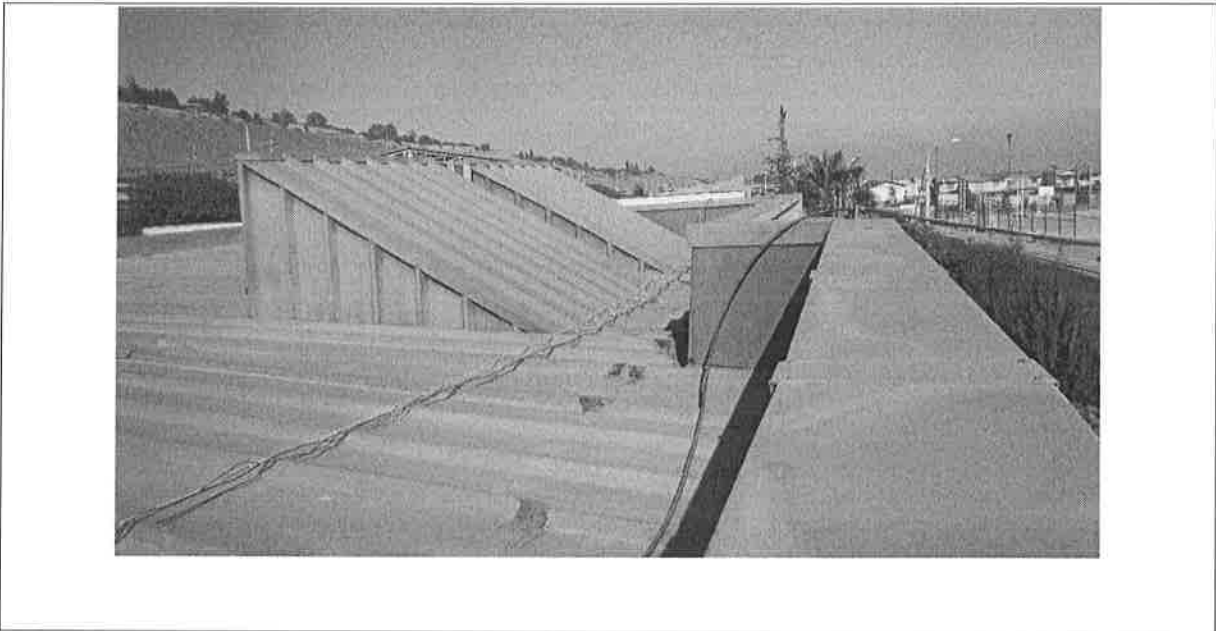
Vista este (Propuesta zona de Inversor)
