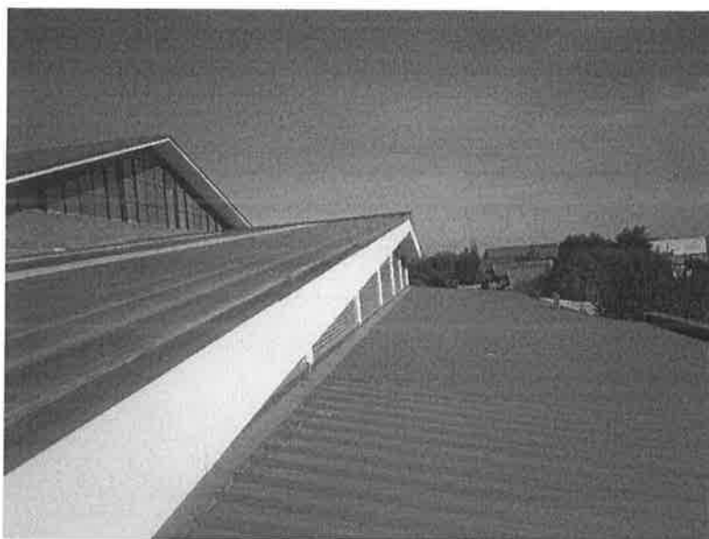
Ilustración: intersección cubiertas
