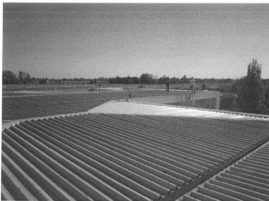
Ilustración: vista sur este, cubierta del edificio.
