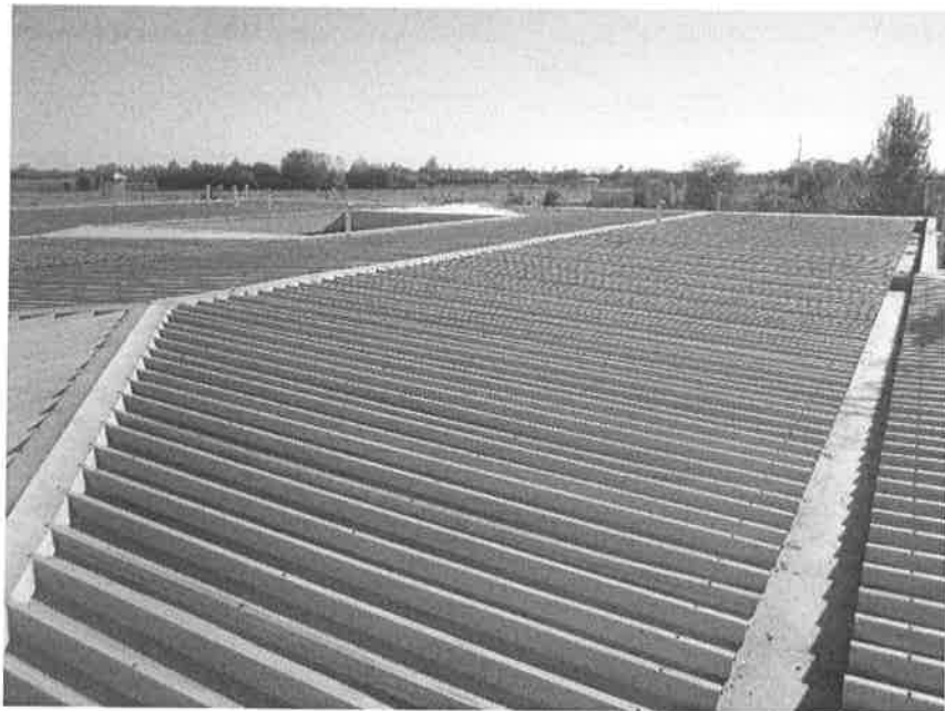
Ilustración: vista sur cubierta edificio.
