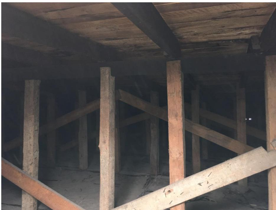
Figura 10.2.4. Estructura y estado de conservación de los tijerales de la cubierta.
