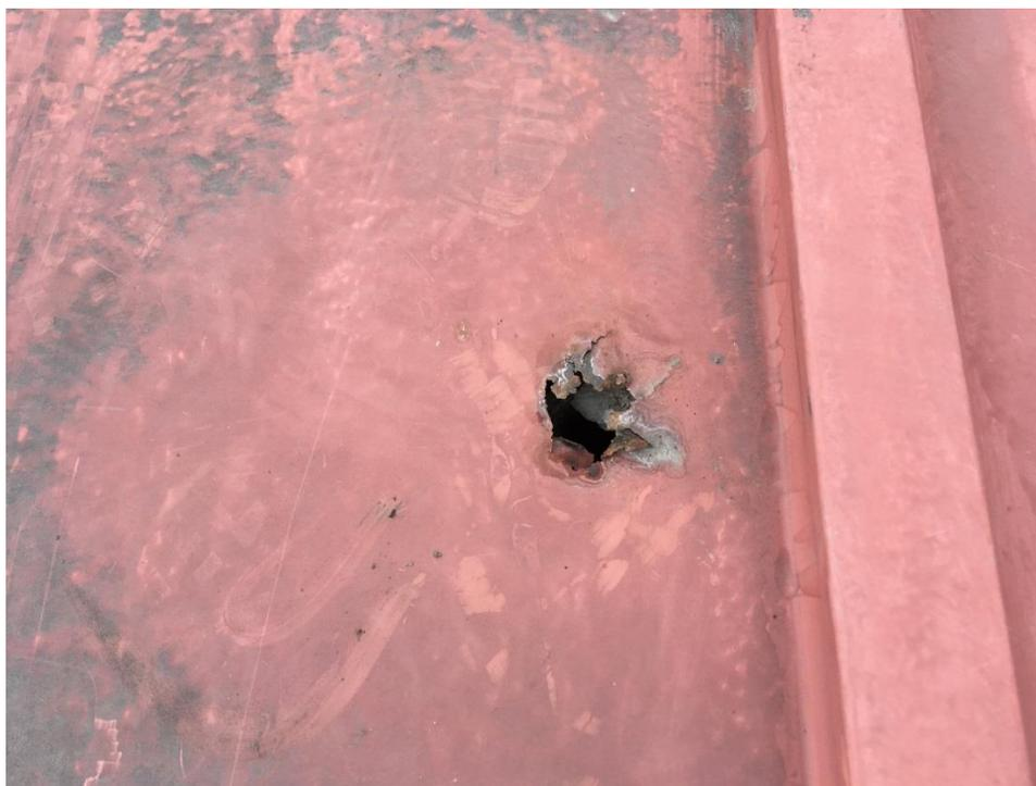
**Figura 10.2.5. Perforación observada en la cubierta.**
