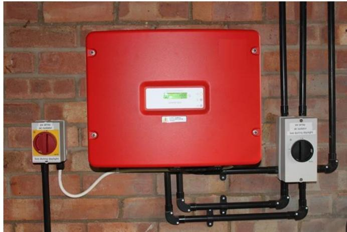
Ilustración -Típico montaje de un inversor
