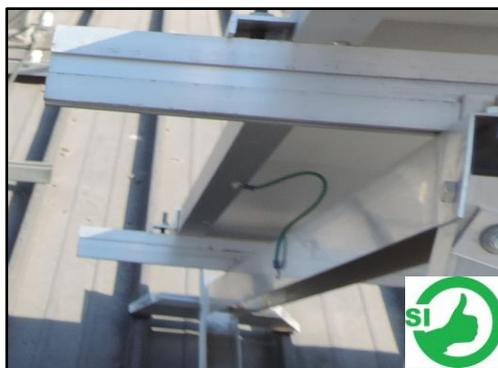
**Figura 113: Conexión de puestas a tierra de los marcos de los módulo**
