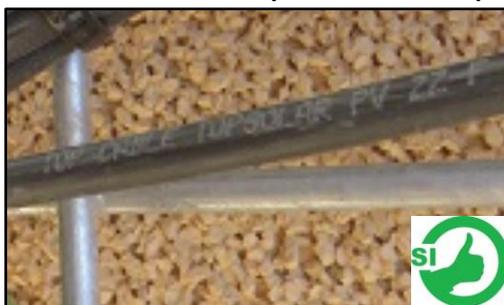
**Figura 103: Ejemplo 2 de conductor rotulado. En este caso particular es del tipo PV1-F**
