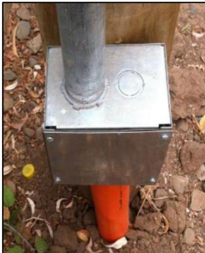
Nota: la forma correcta de realizar el cambio de ducto no metálico a otro metálico a nivel de suelo, es a través de una cámara o de una caja a este nivel. Esto es debido a que la tubería de PVC se encuentra expuesta a daños mecánicos y a la radiación solar, aunque se encuentre sólo algunos centímetros sobre la tierra.
