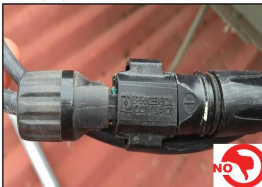
**22. Partes metálicas de la instalación están protegidos contra tensiones peligrosas. Esto incluye las estructuras de soporte, módulos y los equipos. (Se debe verificar que las uniones estén bien afianzadas, de modo que si se quita un módulo del circuito de la UG no se interrumpa la continuidad de ningún conductor de la puesta a tierra de protección)**
