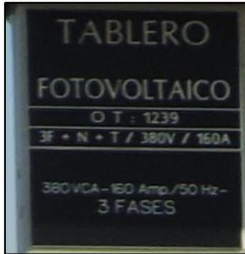
Figura 61: Ejemplo de señalización para un tablero eléctrico
