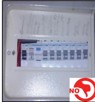
**7. La UG cuenta en el tablero general o de distribución, con un interruptor magnetotérmico. (Bipolar para instalaciones monofásicas y tetrapolar para instalaciones trifásicas)**
