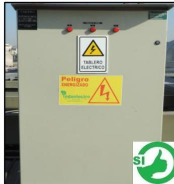
Figura 62: Ejemplo 1 de componentes rotulados dentro de un tablero eléctrico
