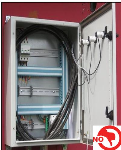
**Figura 69: Ejemplo de tablero que cuenta con cubierta cubre equipos y no sólo presenta puerta exterior**
