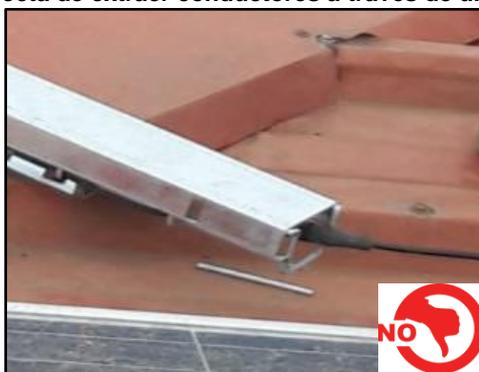
**Figura 79: Ejemplo 2 de forma incorrecta de extraer conductores a través de una bandeja**
