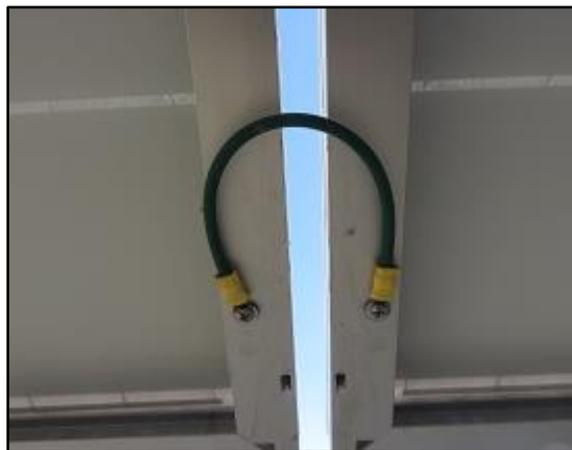
**Figura 36: Conexión de puesta a tierra del marco de un módulo con la estructura**
