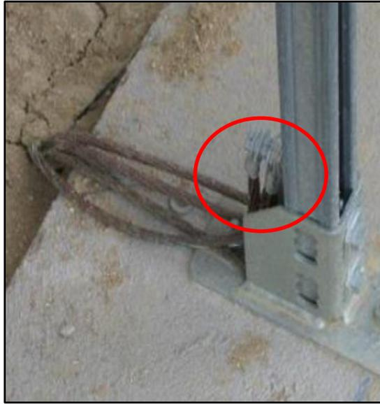
**Figura 32: Puesta a tierra de un elemento de la estructura que no está en contacto directo con un pilar que se encuentra aterrizado**
