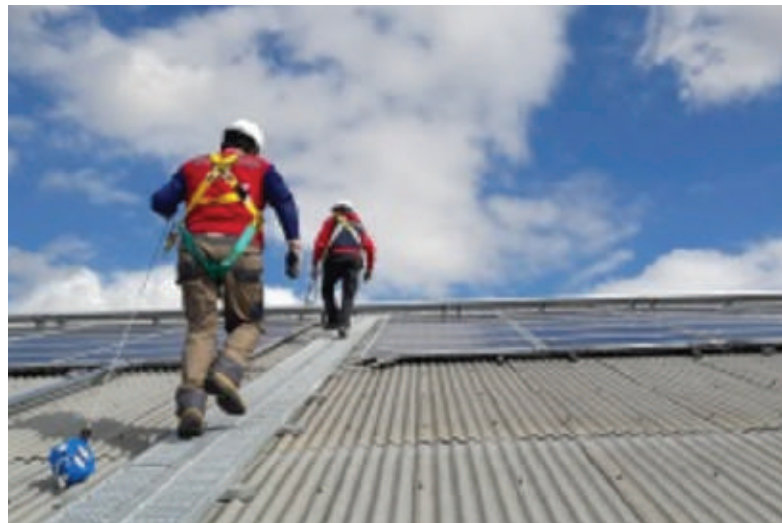
Ilustración 17 Ejemplo de medidas de seguridad para protección contra caídas (Fuente: Ministerio de Energía)
