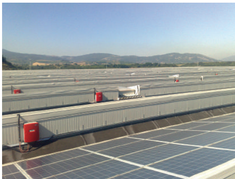
Ilustración 27 Inversores desprotegidos del efecto de radiación solar directa (Fuente: DGS Berlin e. V.)
