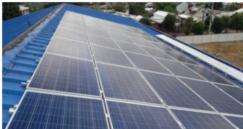
Ilustración 5 Estructura de soporte de módulos FV paralelos al techo (Fuente: Ministerio de Energía)
