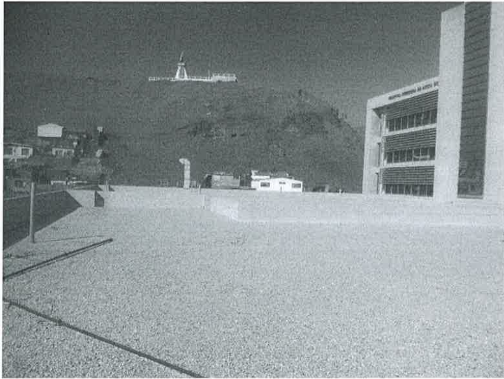
Techo 2 Sobre sector piso mecánico.
