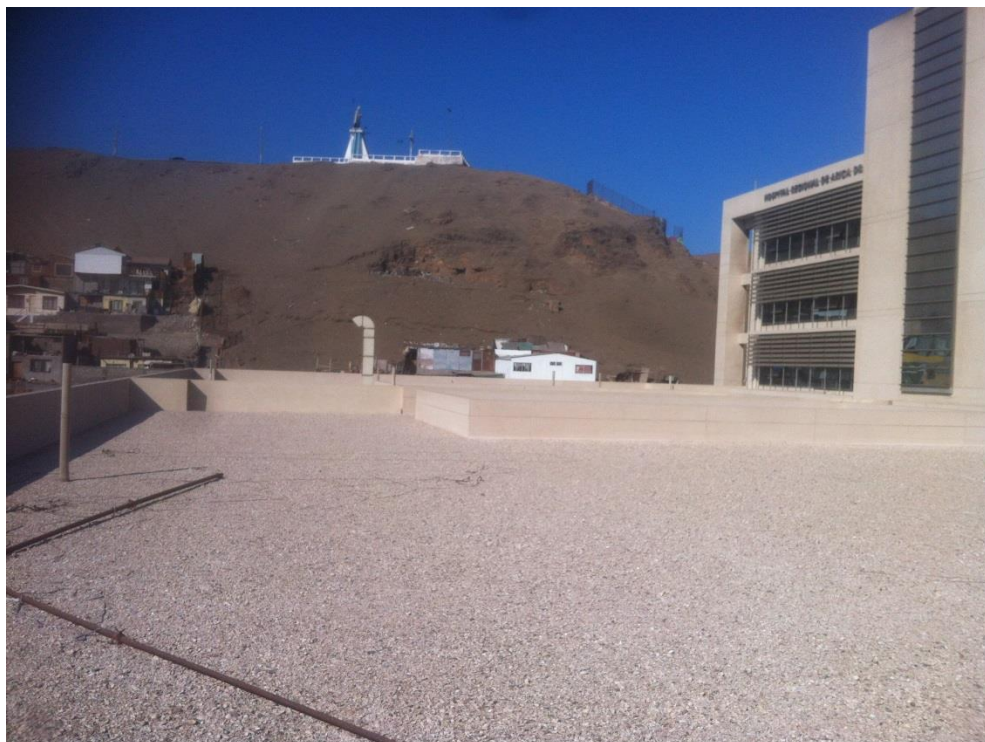
Ilustración – Techo seleccionado 2
