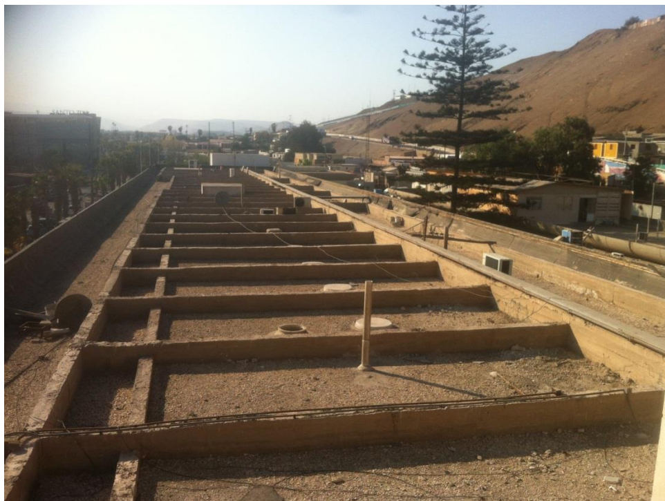
Ilustración – Techo seleccionado 1
