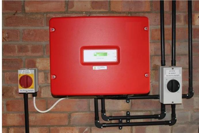
Ilustración -Típico montaje de un inversor
