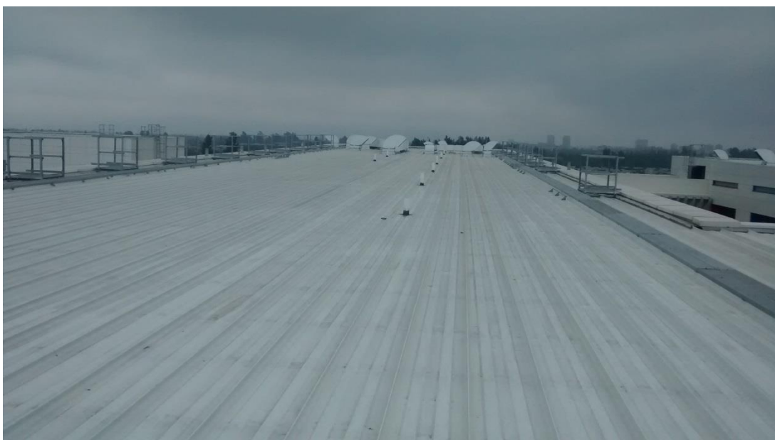
Ilustración – Techo seleccionado
