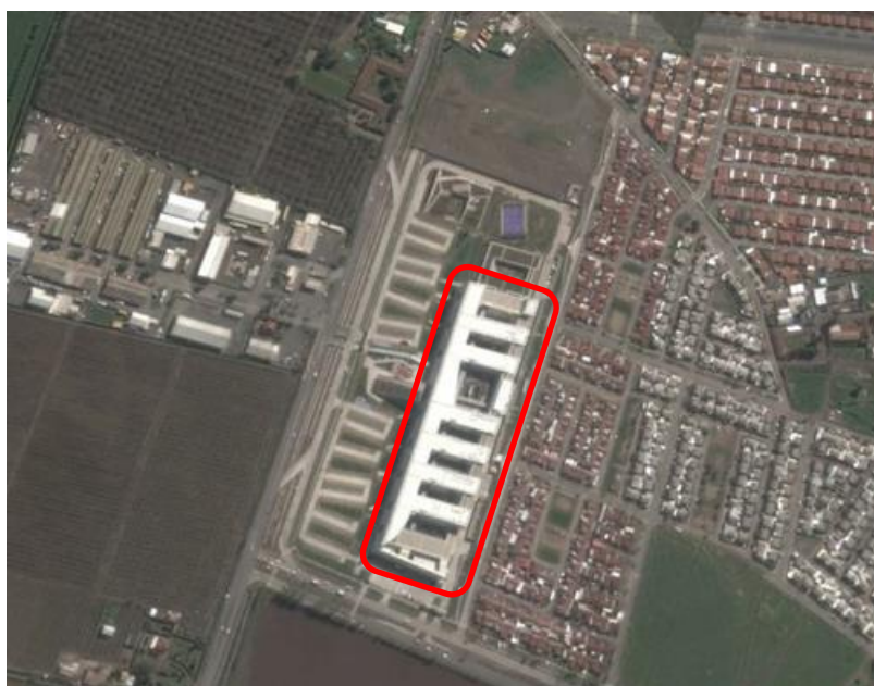
Ilustración - Ubicación del edificio por Google Earth
