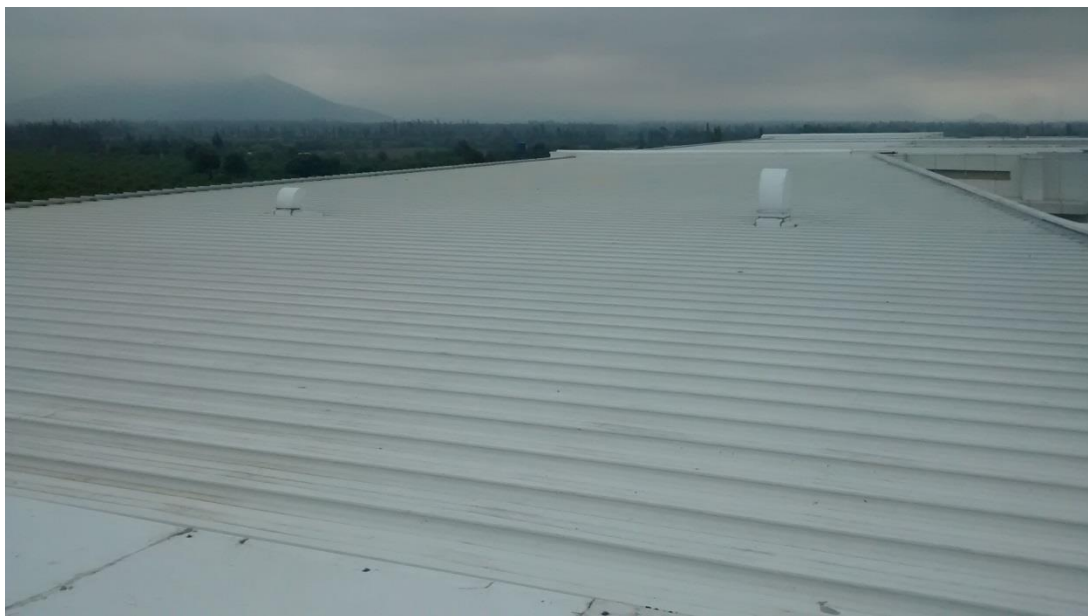
Ilustración – Techo seleccionado
