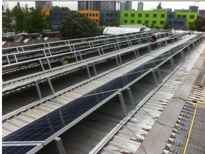
**Ilustración 10 - Estructura de anclaje típico para módulos fotovoltaicos inclinados sobre cubierta. Foto proyecto Teletón Santiago, Programa Techos Solares Públicos.**
