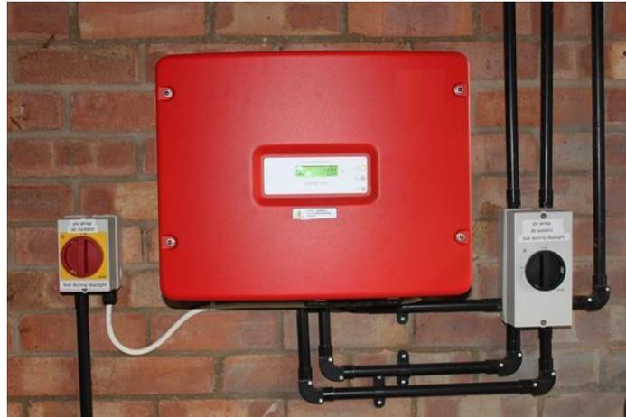
Ilustración 9 – Montaje típico de un inversor
