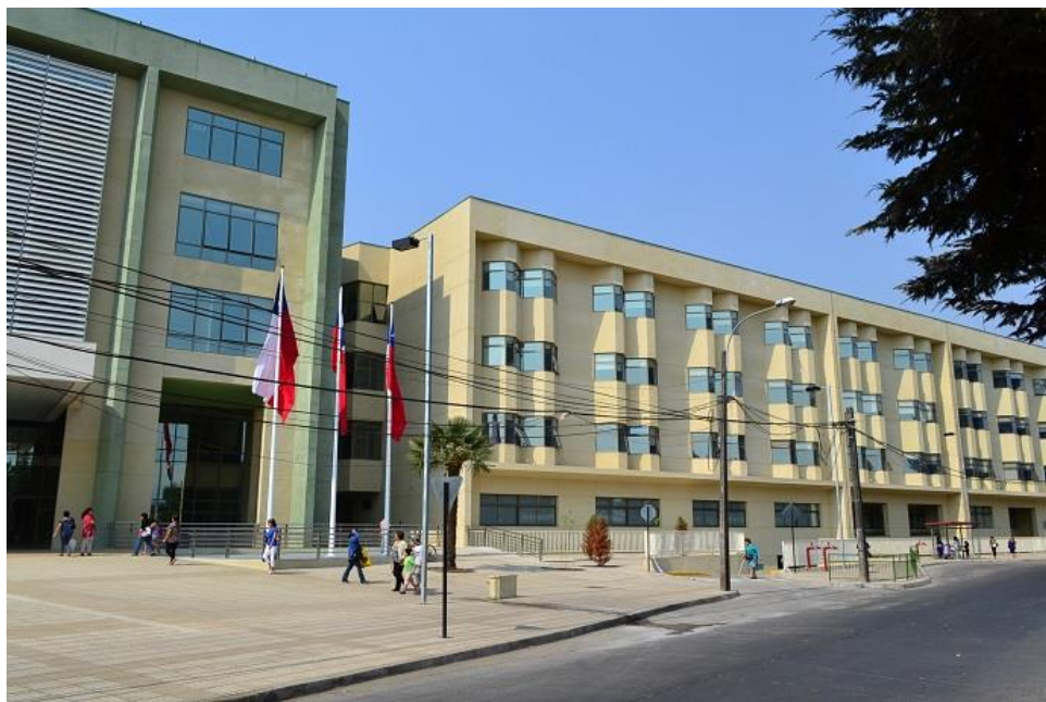
Ilustración 2 - Fachada edificio seleccionado
