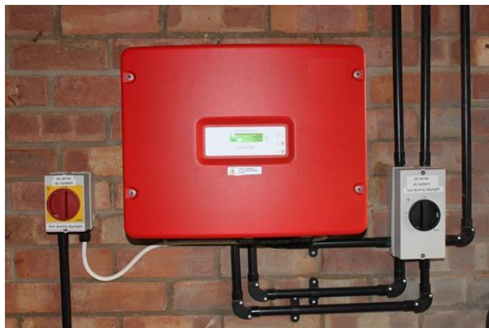
Ilustración 9 – Montaje típico de un inversor
