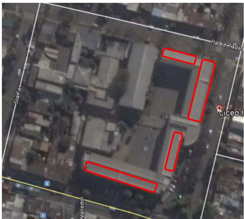
Ilustración 3 - Ubicación del edificio por Google Earth
