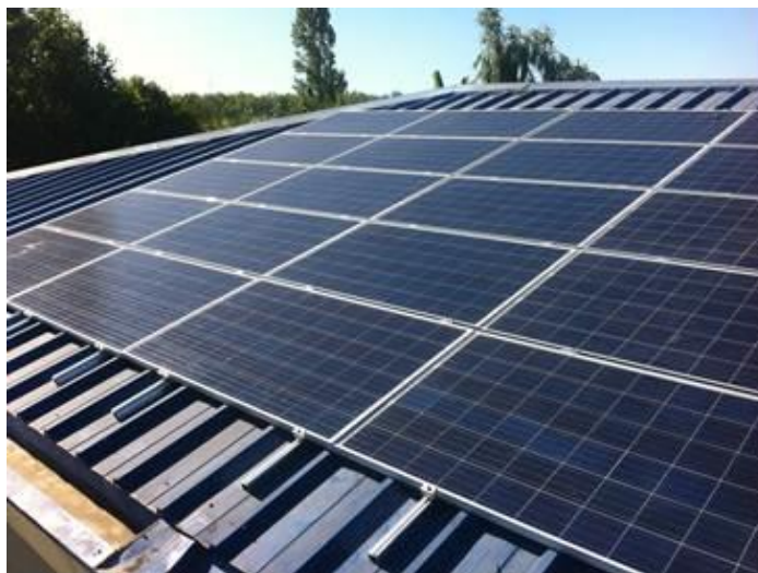
Ilustración 10 - Estructura de anclaje típico para módulos fotovoltaicos paralelos a cubierta. Foto proyecto Juzgado Garantía de Parral, Programa Techos solares Públicos..
