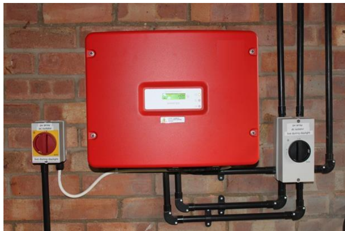
Ilustración 9 – Montaje típico de un inversor
