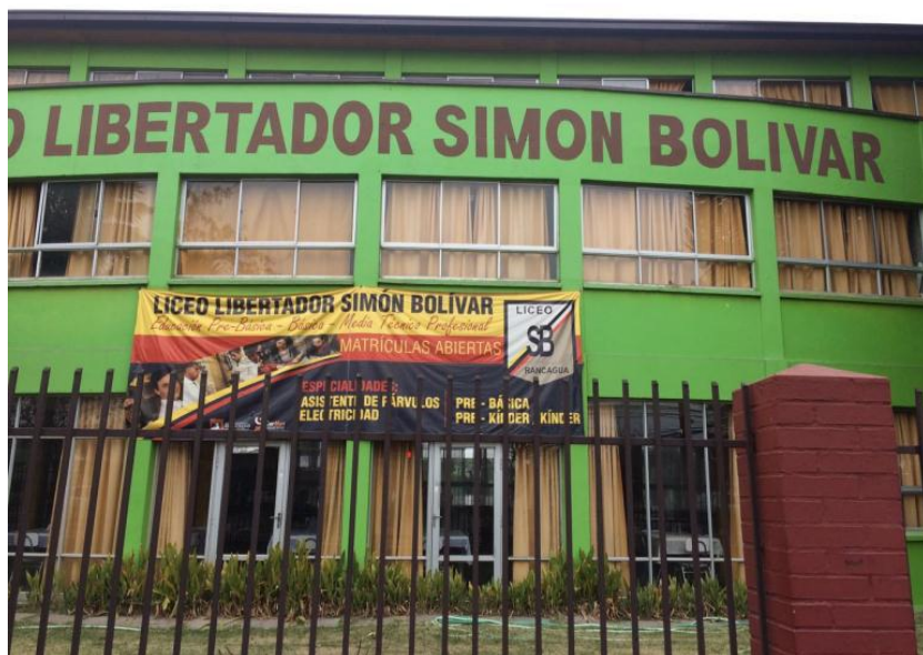
Ilustración 2 - Fachada edificio seleccionado
