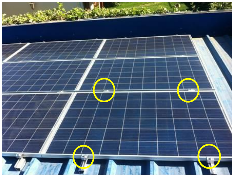
Ilustración 13 - fotografía proyecto Juzgado de Garantía de Parral. En amarillo las grapas finales e intermedia solidarias a la estructura de soporte, la que a su vez se fija a las costaneras de la techumbre del edificio
