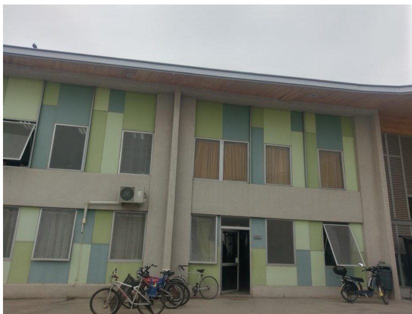
Ilustración 2 - Fachada edificio seleccionado
