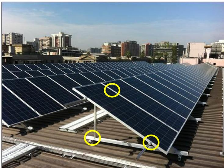
Ilustración 13 - fotografía proyecto GAM Santiago. En amarillo las grapas finales e intermedia solidarias a la estructura de soporte, la que a su vez se fija a las costaneras de la techumbre del edificio
