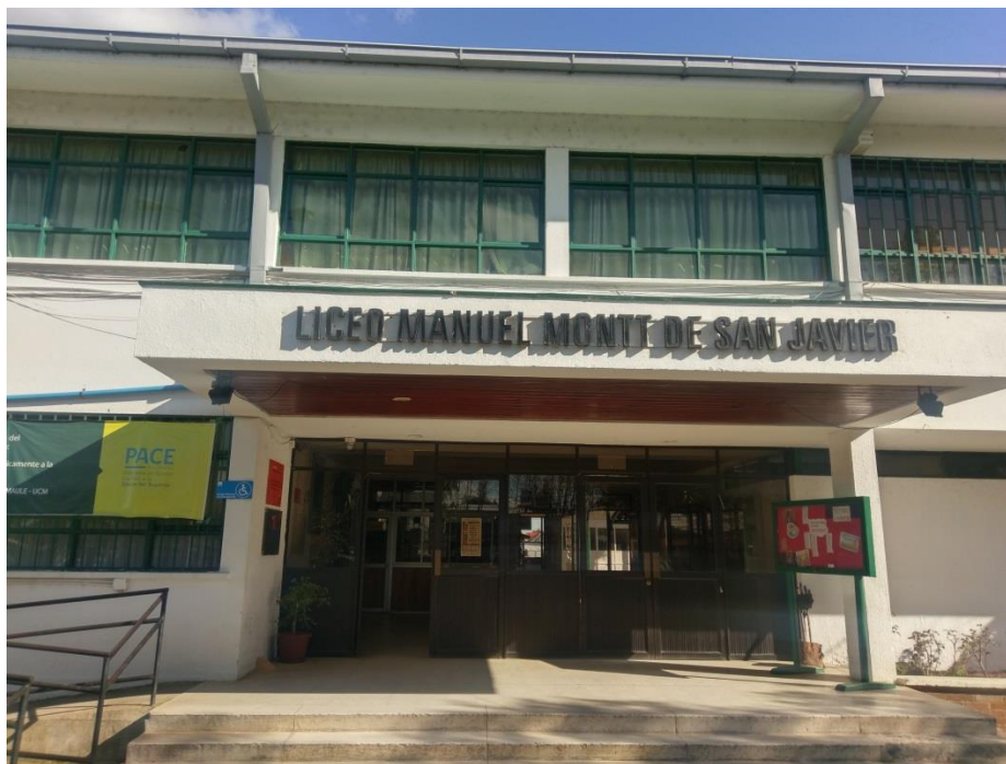
Ilustración 2 - Fachada edificio seleccionado
