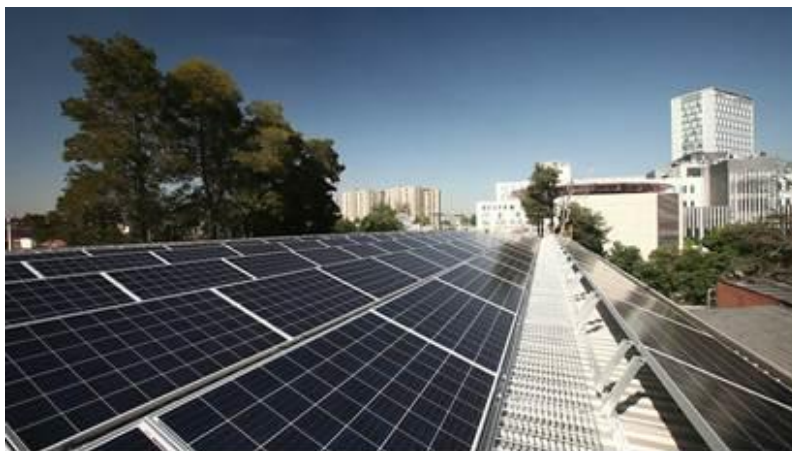
Ilustración 8 - Modulo fotovoltaico tipo, potencia de 250 W, dimensión de 1,6m x 1m. Peso aproximado 156 Kg. foto Proyecto Teletón Santiago, Programa Techos solares Públicos.
