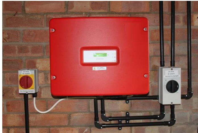
Ilustración 9 – Montaje típico de un inversor
