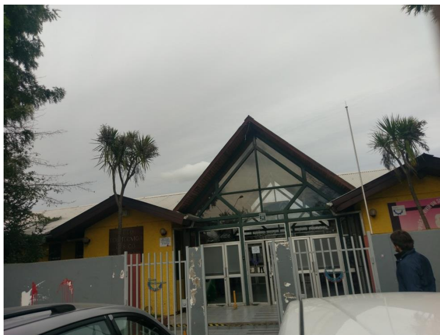
Ilustración 2 - Fachada edificio seleccionado
