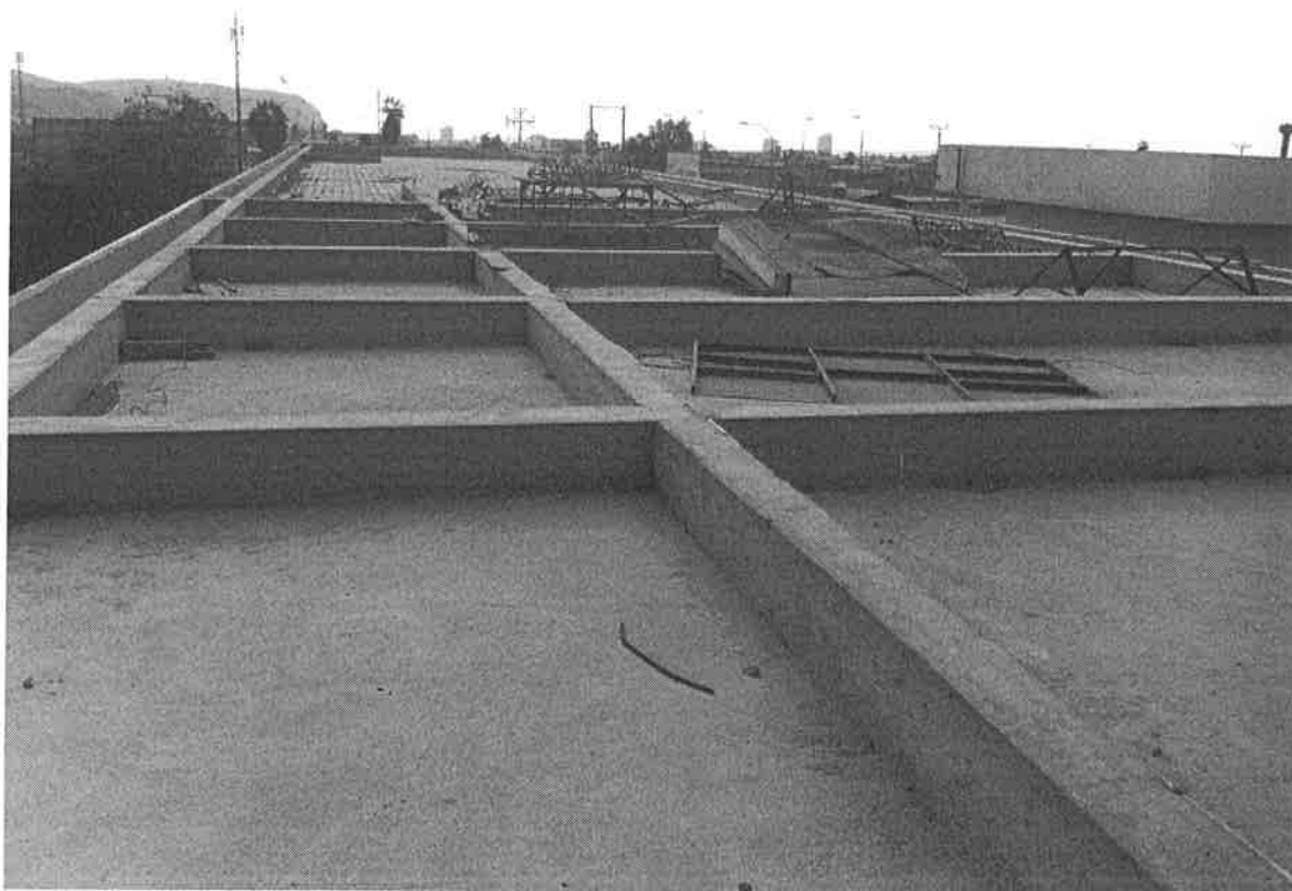
Techo 1 Edificio Administración
