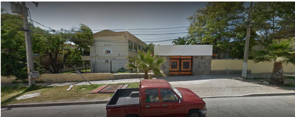
Ilustración - Fachada edificio seleccionado
