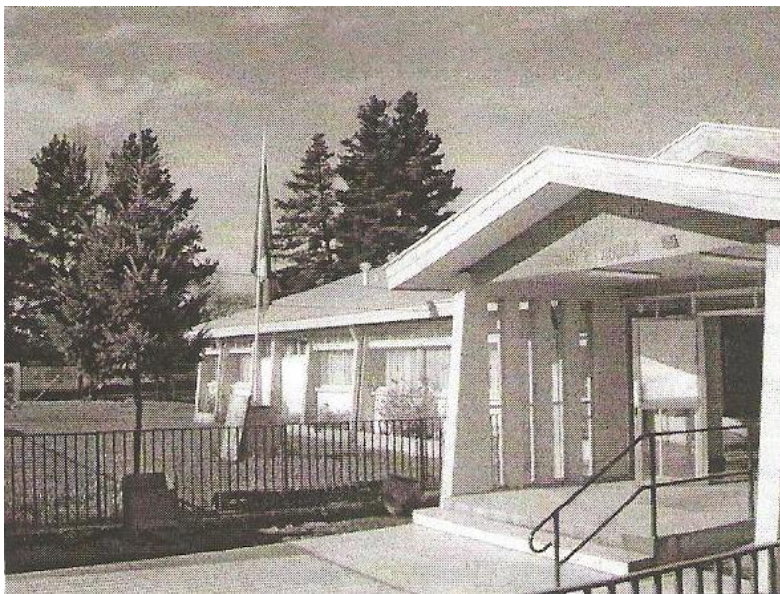
Ilustración - Fachada edificio seleccionado
