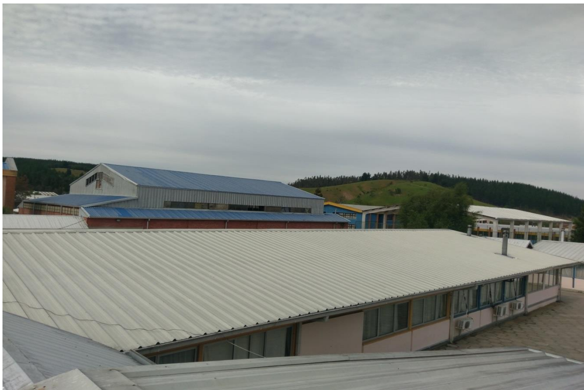
Ilustración – Techo seleccionado 1
