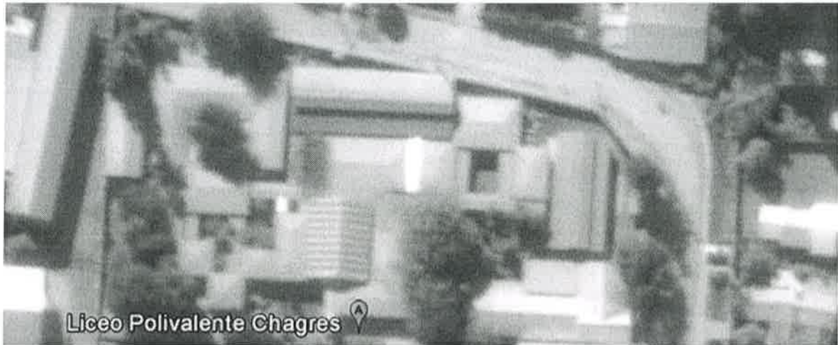
Ilustración - Ubicación del edificio por Google Earth.
