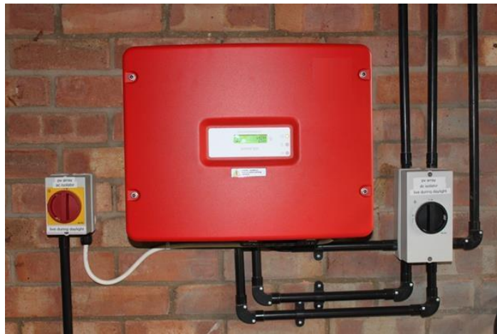
Ilustración -Típico montaje de un inversor
