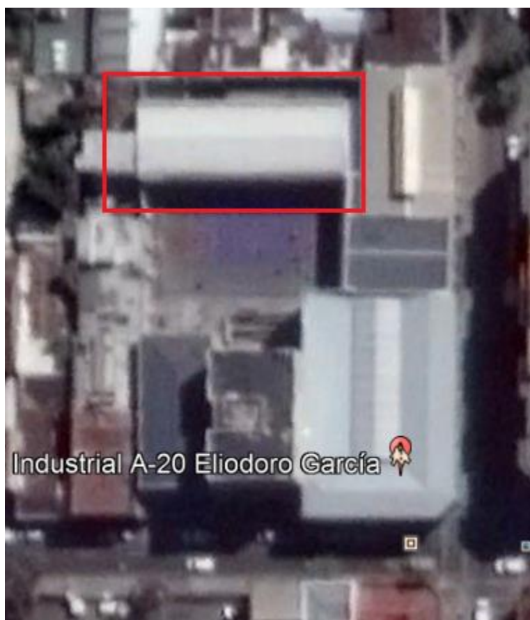
Ilustración: Ubicación del edificio por Google Earth
