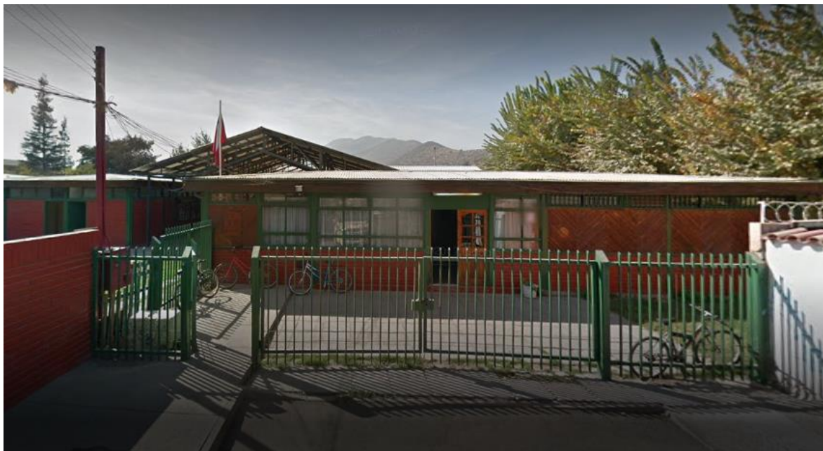
Ilustración - Fachada edificio seleccionado
