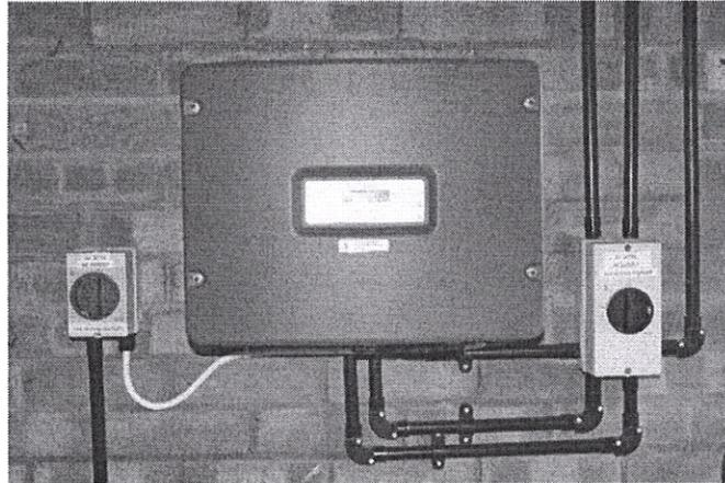
Ilustración -Típico montaje de un inversor
