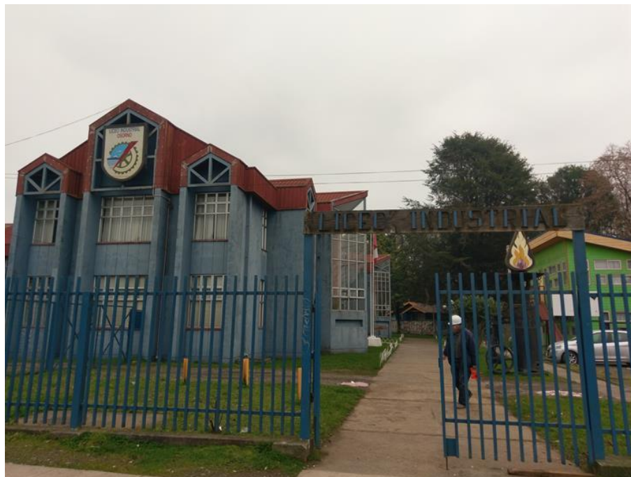
Ilustración - Fachada edificio seleccionado.
