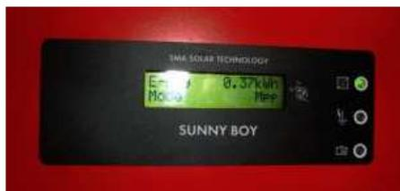
**ILUSTRACIÓN 12 EJEMPLO DE UN INVERSOR INDICANDO BUEN FUNCIONAMIENTO, BAJO LA LUZ VERDE UNA LUZ ROJA INDICARÁ UNA FALLA A TIERRA.**
