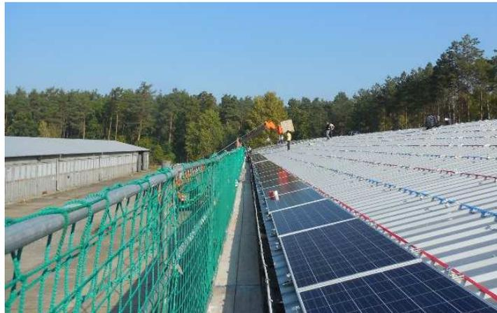
**ILUSTRACIÓN 16 EJEMPLO PROTECCIÓN ANTICAÍDA TECHO INCLINADO
