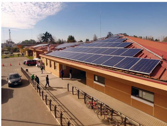
**ILUSTRACIÓN 8 ESTRUCTURA DE SOPORTE DE MÓDULOS FV PARALELOS AL TECHO (FUENTE: MINISTERIO DE ENERGÍA)**
