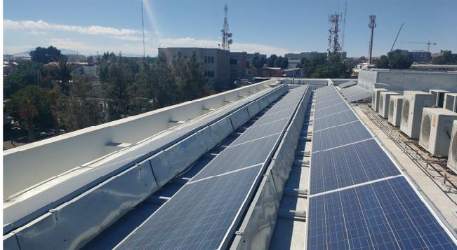
**ILUSTRACIÓN 5 PLANTA FOTOVOLTAICA LASTRADA EN FISCALÍA DE CALAMA (FUENTE: MINISTERIO DE ENERGÍA)**
