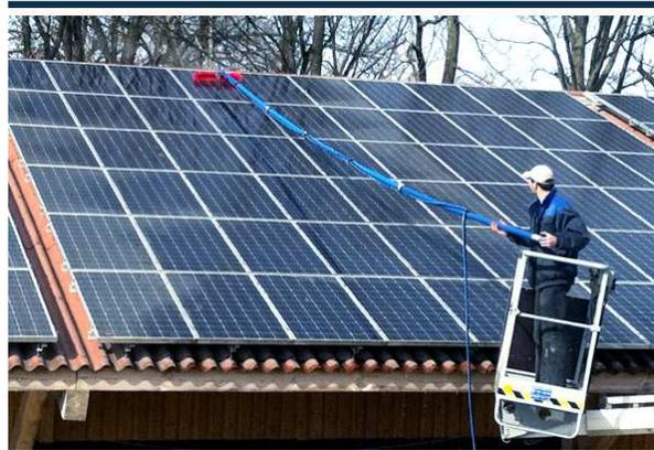
**ILUSTRACIÓN 18 PLATAFORMA ELEVADORA Y EQUIPO DE PROTECCIÓN PERSONAL**
