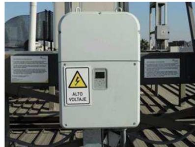
**ILUSTRACIÓN 4 INVERSOR DE 33 kW**
