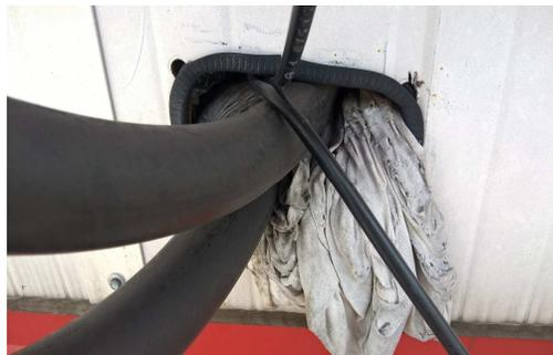
**ILUSTRACIÓN 58 FALTA DE SELLADO DE LOS TUBOS DE ACOMETIDA
