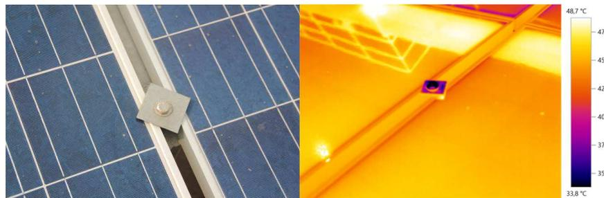
**ILUSTRACIÓN 64 SUJECIÓN DE LOS MÓDULOS CON ABRAZADERAS INADECUADAS (FUENTE: PI BERLÍN AG)**
