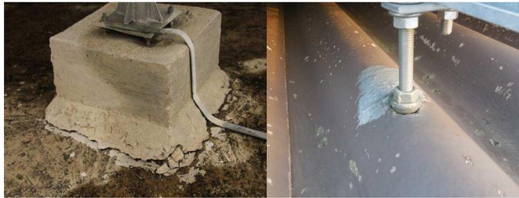
ILUSTRACIÓN 68 IZDA: PÉRDIDA DE ANCLAJE DE LA ZAPATA DE HORMIGÓN A LA SUPERFICIE DEL TEJADO (FUENTE: PI BERLÍN AG); DCHA: FALTA DE SELLADO DE LOS ORIFICIOS DE PENETRACIÓN (FUENTE: PI BERLÍN AG)
