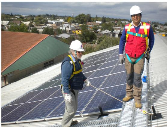
**ILUSTRACIÓN 20 EJEMPLO DE MEDIDAS DE SEGURIDAD PARA PROTECCIÓN CONTRA CAÍDAS
