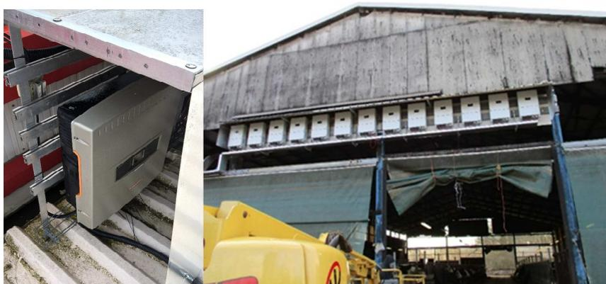
**ILUSTRACIÓN 42 INVERSORES DIFÍCILMENTE ACCESIBLE PARA EL PERSONAL DE O&M
