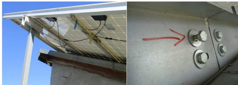
**ILUSTRACIÓN 65 IZDA: SUJECIÓN DE LOS MÓDULOS A LA ESTRUCTURA DEL TEJADO CON CINTAS DE AMARRE (FUENTE: PI BERLÍN AG); DCHA: AFLOJAMIENTO DE LOS TORNILLOS DE SUJECIÓN DE LOS PERFILES TRANSVERSALES (FUENTE: PI BERLÍN AG)**
