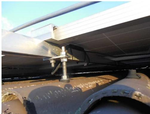
**ILUSTRACIÓN 6 PLANTA FOTOVOLTAICA ANCLADA MEDIANTE PENETRACIÓN (FUENTE: PI BERLIN AG)**
