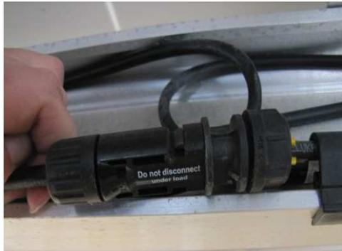
**ILUSTRACIÓN 57 RADIO DE CURVATURA INSUFICIENTE
